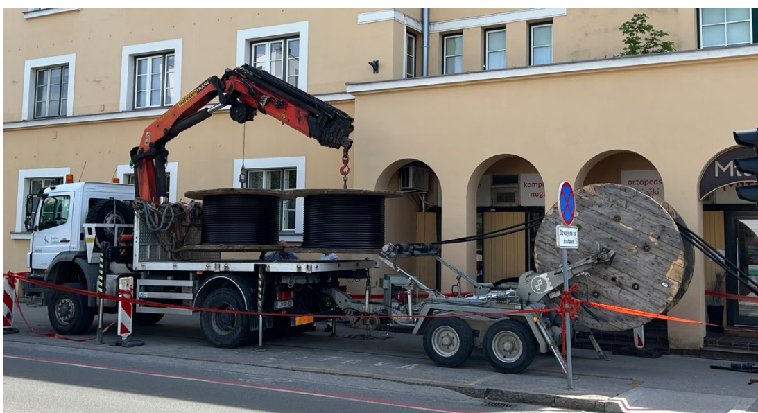
Slika 9: Priprava na polaganje SN KB (Lastni vir)
