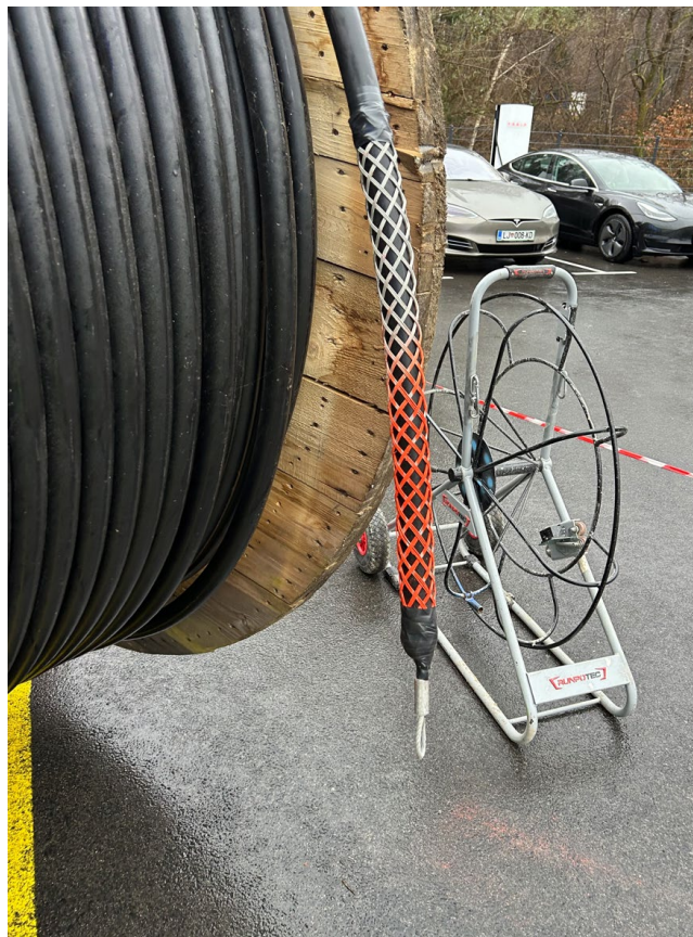
Slika 14: Namestitev vlečne nogavice na SN kabel NA2XS(FL)2Y 1x400/35 RM (Lastni vir)
