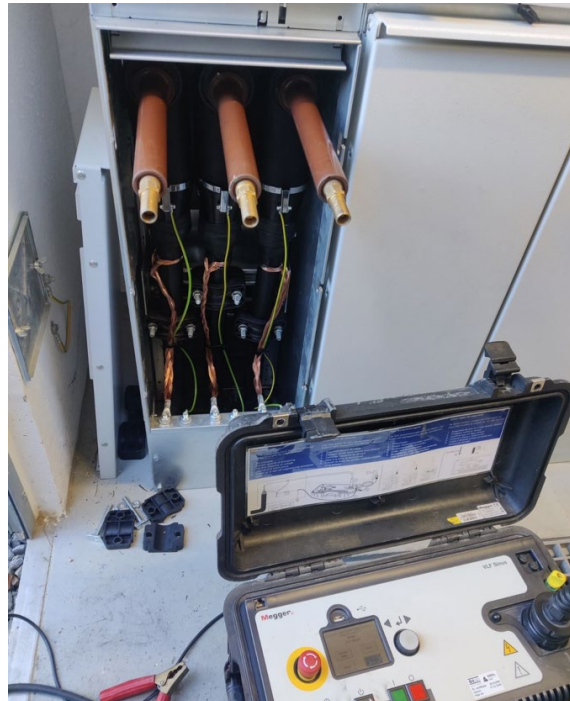
Slika 15: Priklop NA2XS(FL)2Y 1x400/35 RM v SN postroj in izvedba meritev (Lastni vir)
