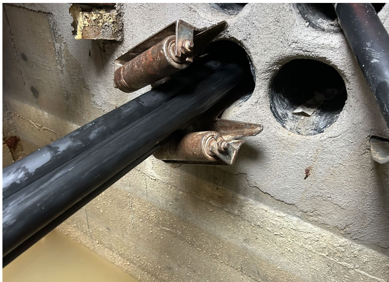
Slika 12: Vleka SN kabla preko uvodnice v kabelskem jašku (Lastni vir)
