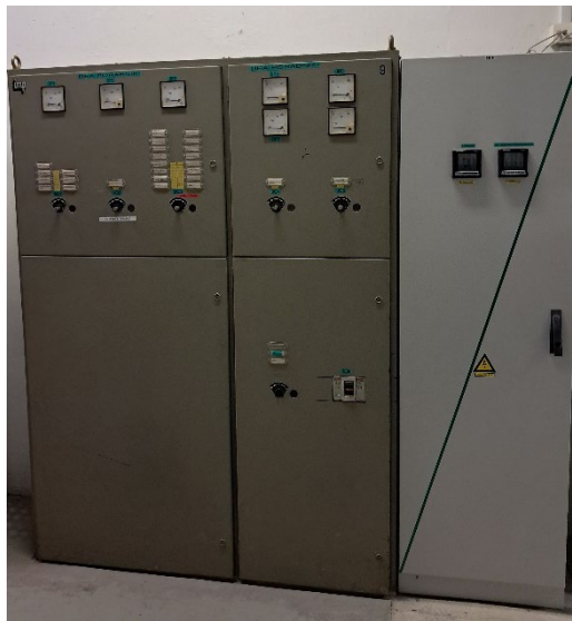
Slika 10: Razdelilne omare (agregat) (Lastni vir)
