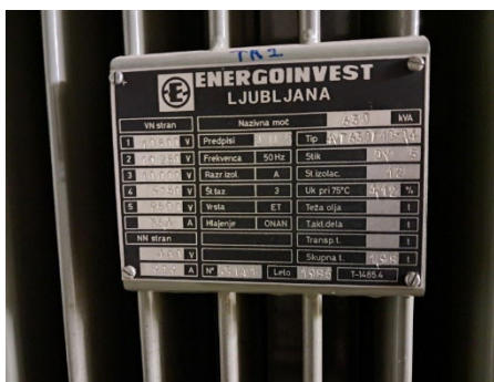
Slika 4: Napisna tablica TR2 (Lastni vir)
