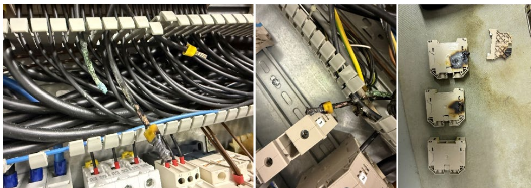
Slika 23: Posledica slabih spojev (Lastni vir)
