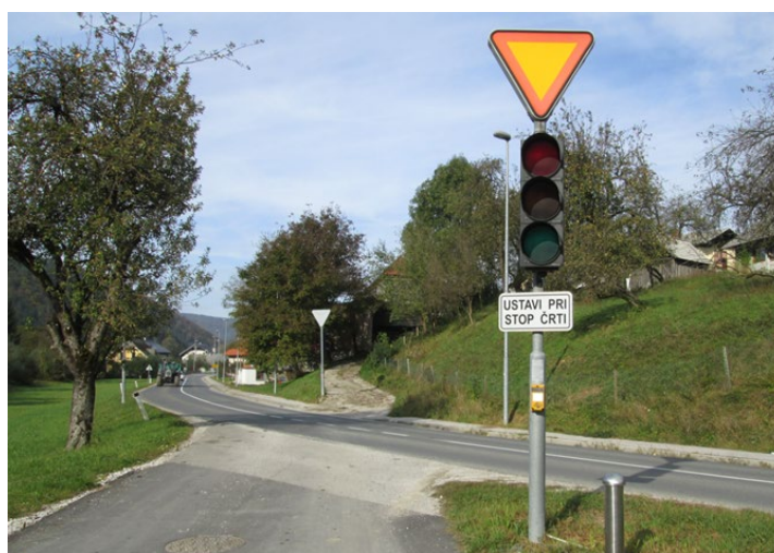
Slika 35: Primer nivojskega prehoda za domače živali in mehanizacijo (Lastni vir)
