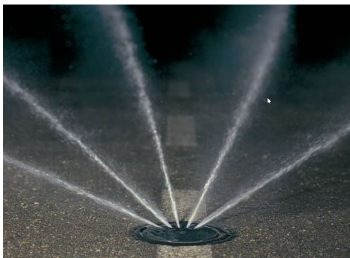
Slika 38: Vgrajena talna šoba med brizganjem slanice na vozišče (Vir: https://www.svet-strojev.com/sl/sistem-za-avtomatsko-soljenje , 2024)
