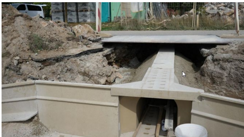
Slika 34: Primer podhoda za dvoživke
