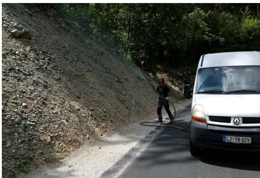
Slika 8: Naprava za brizganje ozelenitve
