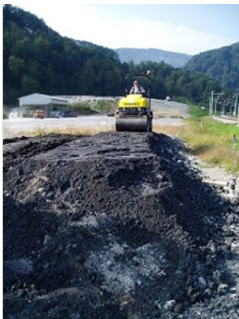
Slika 1: Izdelava testnega polja (Vir: Lastni)
