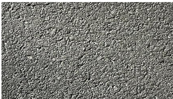
Slika 16: Videz vozne površine z obrabno plastjo bituminizirane zmesi bitumenskega betona AC surf 11 (Vir: Henigman et. al., 2016)
