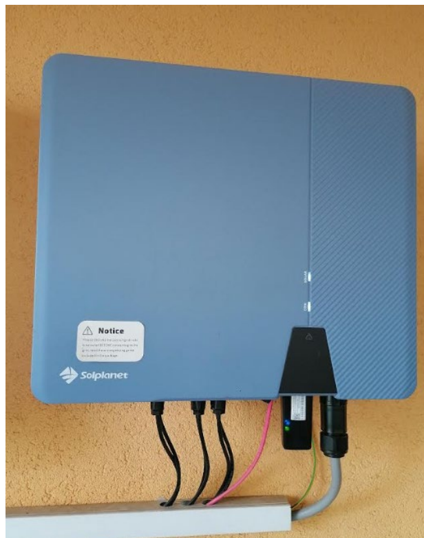
Slika 5: Razsmernik sončne elektrarne Omahen (Lastni vir)
