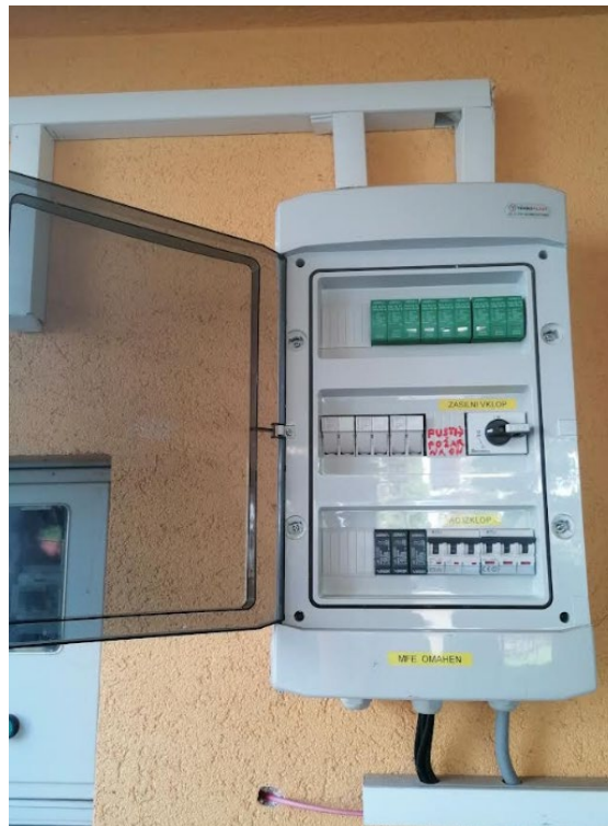
Slika 6: Merilno mesto sončne elektrarne Omahen (Lastni vir)
