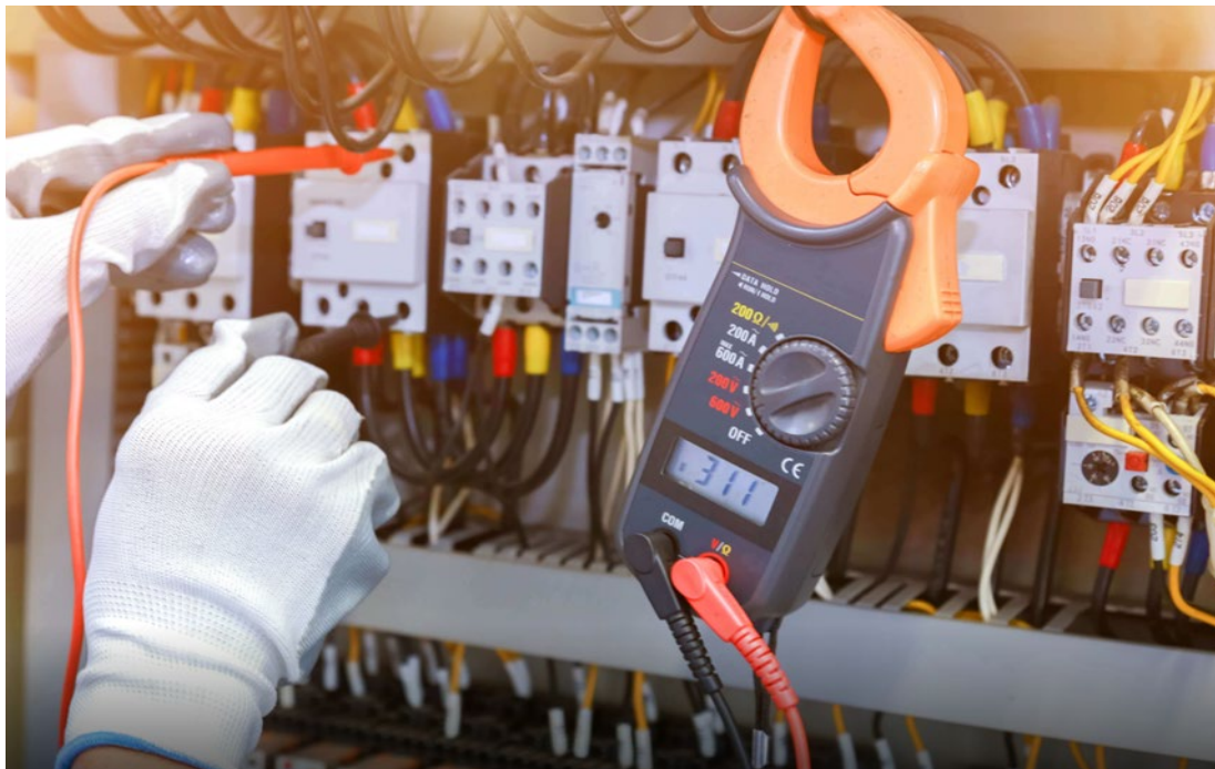
Slika 3: Elektro vzdrževanje (Vir: Shutterstock portal, 2025)
