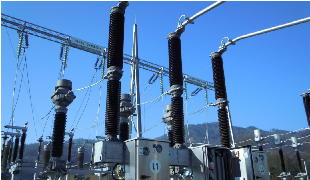
Slika 18: Odklopnik Q0 (Lastni vir)
