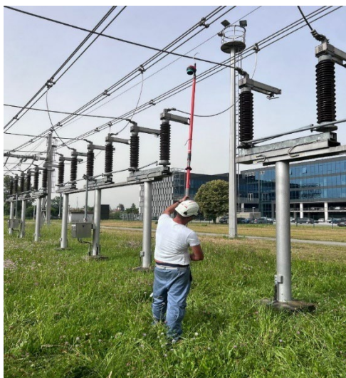
Slika 13: Preverjanje breznepetostnega stanja z VN indikatorjem (Lastni vir)
