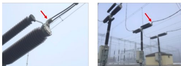
Slika 17: Pregrevanje spoja – slika odklopnika (Vir: Terming, 2024)
