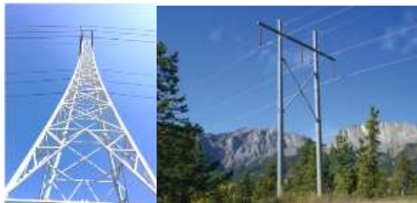
Slika 13: FRP izvedba SM – slika levo, 110 kV kompozitni SM (cevna izvedba) – slika desno
