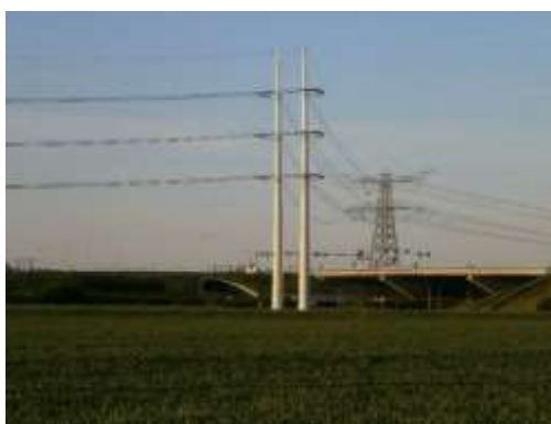
Slika 15: Nova zasnova SM z dvojnimi krogi in kombinacija kovinskih drogov, grajen je na Nizozemskem (Vir: ENTSO-E, 2021)
