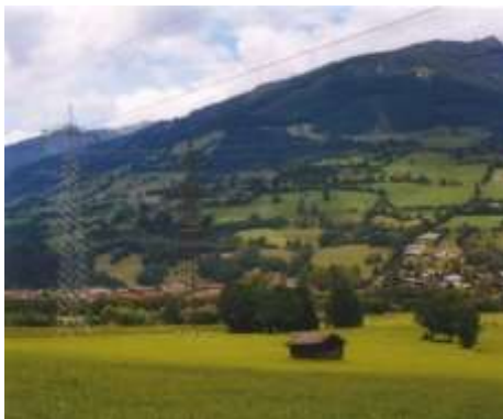
Slika 16: Vidna sta dva dvosistemska 400 kV SM. Levi SM: iz pocinkanega jekla – jasno viden; desni SM: stolp "kamuflačne linije" temno zelene barve in prevlečeni vodniki, skoraj nevidni (Lastni vir)
