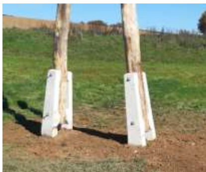
Slika 4: Betonske klešče nameščene na A drog (Lastni vir)
