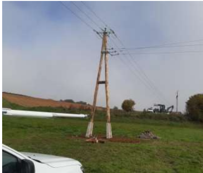
Slika 36: Končna podoba novega A-droga (Lastni vir)
