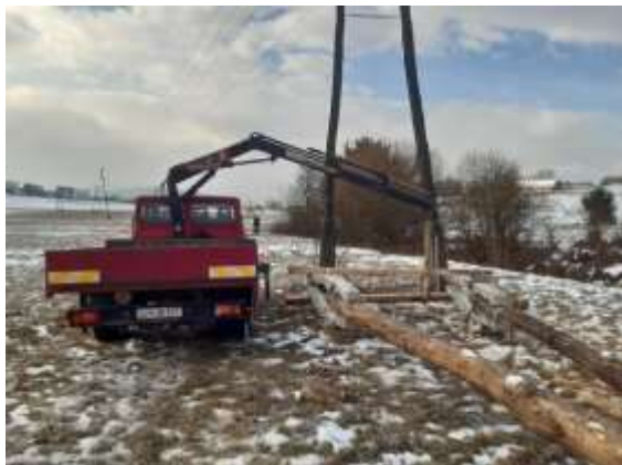
Slika 5: Sestavljanje razbremenilnega A-droga (Lastni vir)
