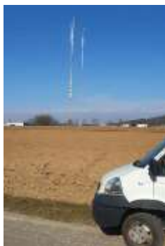
Slika 29: Ozemljen 20 kV daljnovod (Lastni vir)
