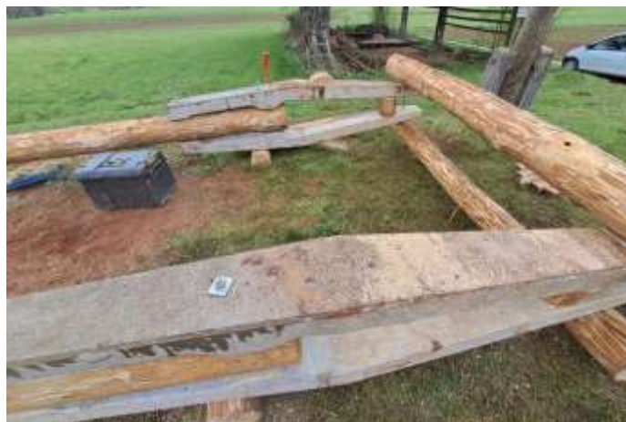
Slika 27: Sestavljanje spodnjega dela A-droga (Lastni vir)
