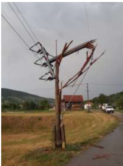
Slika 24: Zlom progovnega stikala (Lastni vir)
