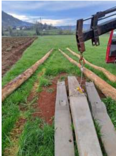
Slika 26: Namestitvev betonskih klešč (Lastni vir)
