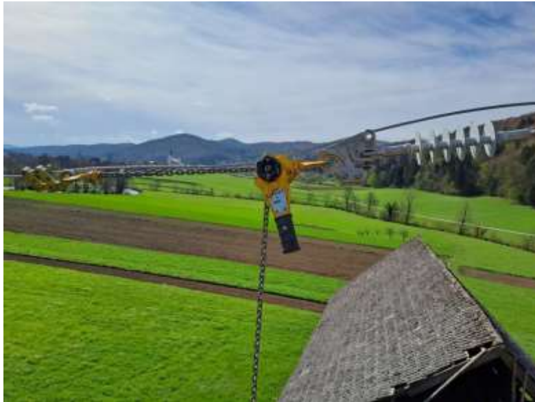
Slika 34: Vpenjanje vodnikov (Lastni vir)
