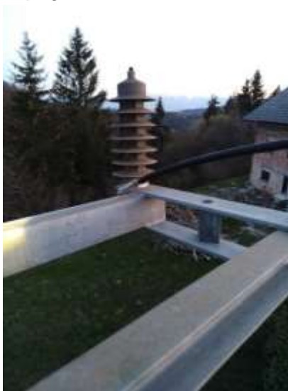
Slika 20: Vodnik na konzoli (Lastni vir)
