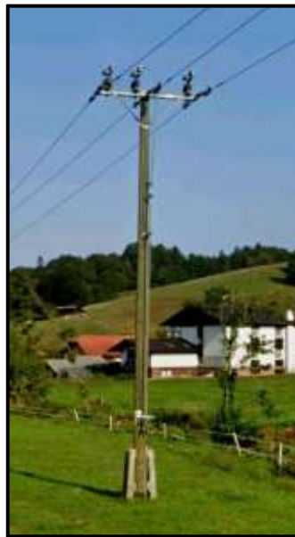
Slika 13: Progovno ločilno stikalo (Lastni vir)
