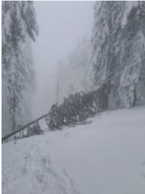
Slika 22: Padlo drevo na daljnovodu (Lastni vir)
