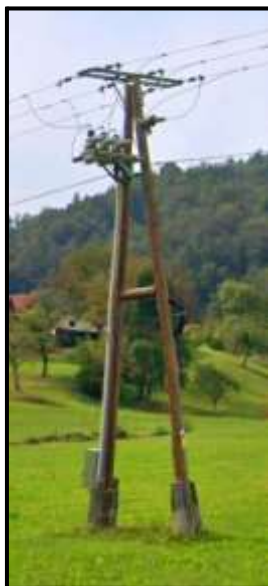
Slika 15: Daljinsko močnostno stikalo na A-drogu (Lastni vir)
