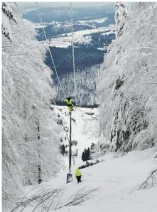
Slika 23: Vpetje vodnikov na izolator (Lastni vir)
