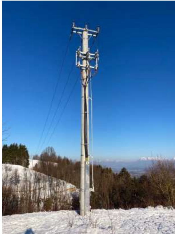
Slika 18: Povezava SN kablov na nadzemne vodnike (Lastni vir)
