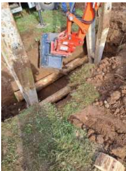
Slika 33: Nastavljanje A-droga na pravo mesto (Lastni vir)
