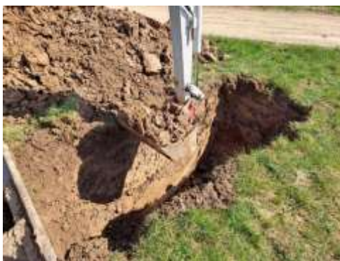
Slika 31: Kopanje izkopa za A-drog (Lastni vir)
