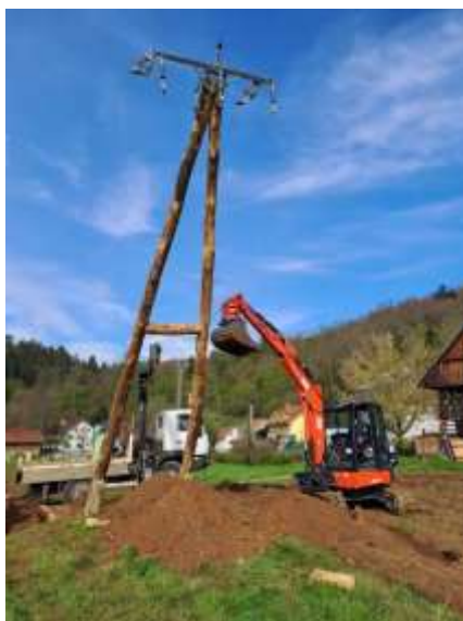
Slika 32: Postavitev A-droga (Lastni vir)
