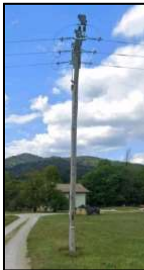
Slika 14: Progovno ločilno stikalo s komorami (Lastni vir)
