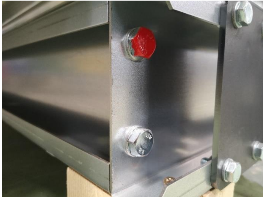
Slika 18: Označena obstoječa povezava naprave izenačitve (Lastni vir)
