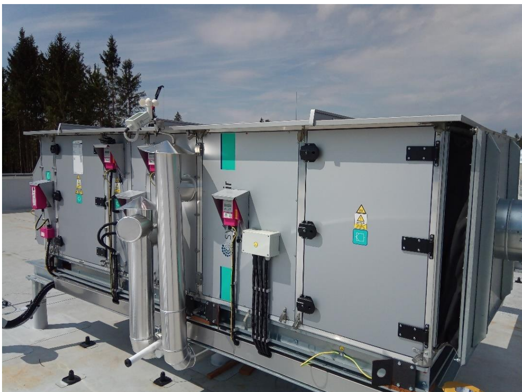
Slika 25: Izvedba elektro inštalacije prežračevalne naprave PN50 Premazovanje (Lastni vir)
