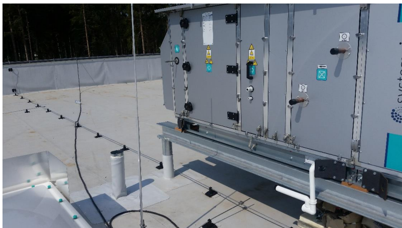
Slika 24: Nameščena prezračevalna naprava PN50 Premazovanje (Lastni vir)
