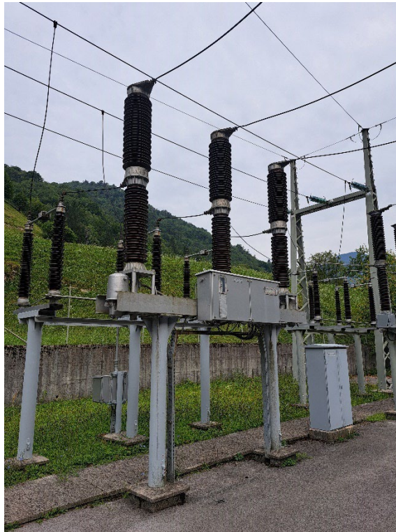
Slika 11: Odklopnik Končar tip K3AR1 (Lastni vir)
