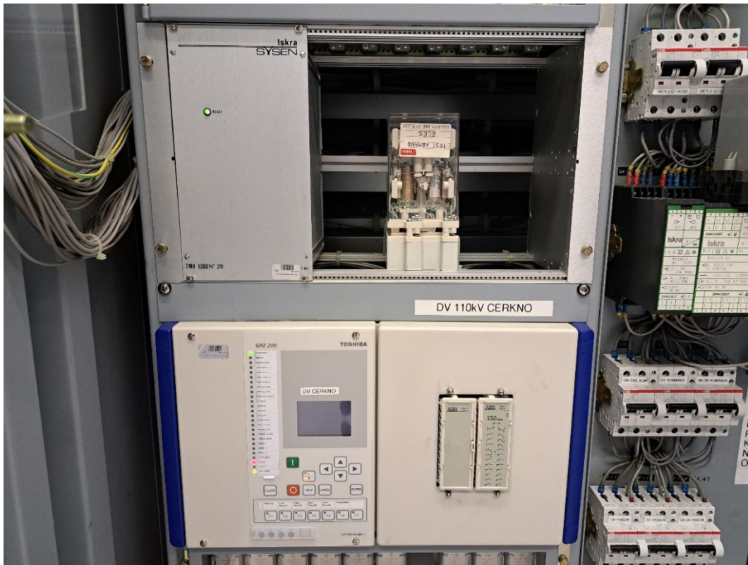
Slika 7: Distančna zaščita in računalnik polja (Lastni vir)
