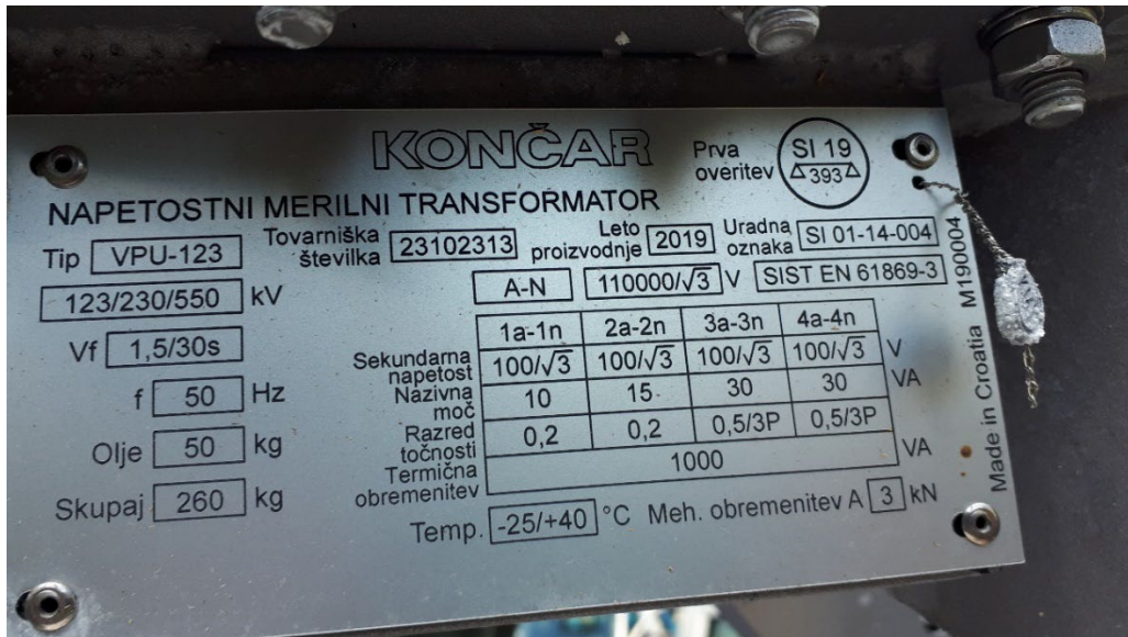
Slika 6: Napetostni merilni transformator (Lastni vir)
