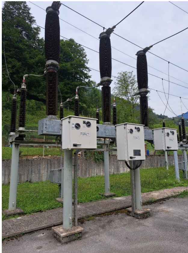
Slika 3: Odklopnik ALSTOM (Lastni vir)
