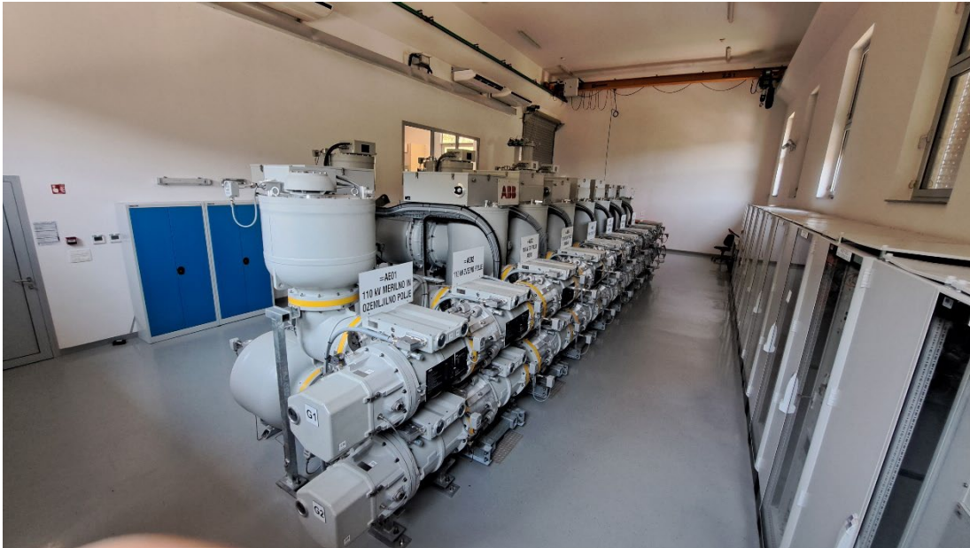
Slika 13: RTP Plave GIS izvedba (Lastni vir)
