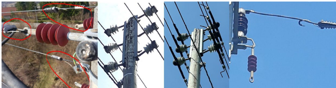
Slika 15: Primer zamenjanih elementov na DV Strelišče (Lastni vir)
