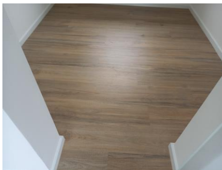
Slika 15: Biološko razgradljiva vinilna talna obloga (Lastni vir)
