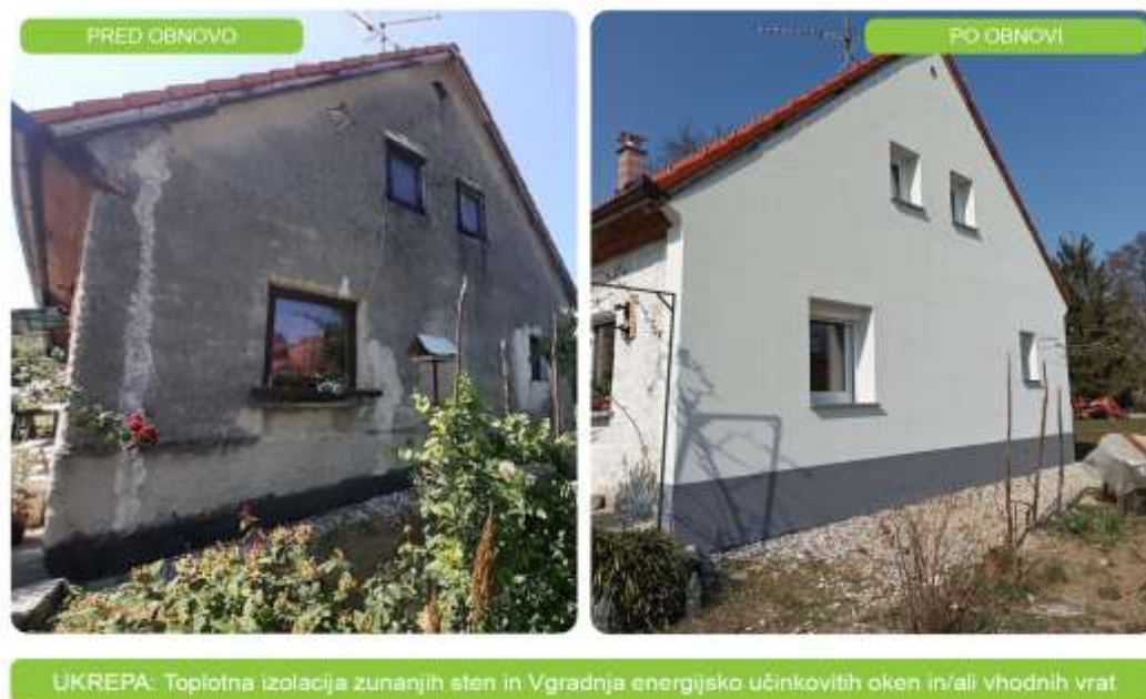
Slika 3: Pred in po obnovi fasade in oken. (Vir: Eko sklad, 2023)
