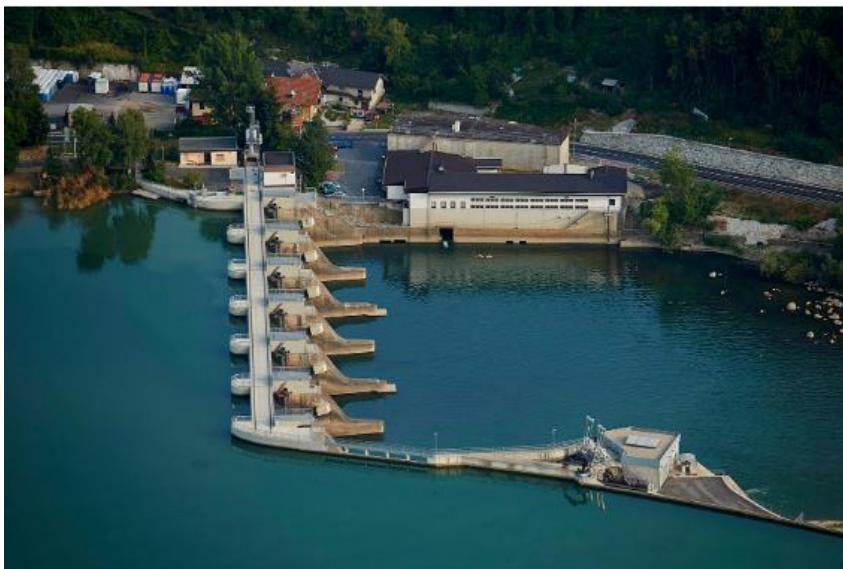
Slika 16: Hidroelektrarna Zlatoličje (kanalski tip) (Vir: HSE Invest, 2014)
