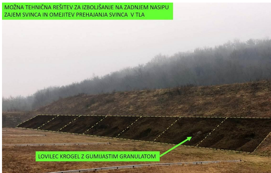
Slika 28: Predlog tehnične rešitve za zajem svinca iz krogel (Vir: Lastni vir)
