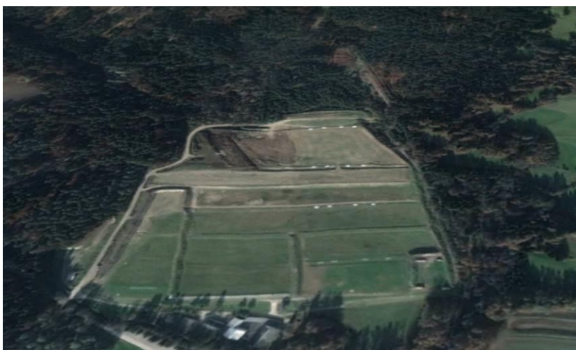
Slika 11: Pehotno strelišče Crngrob (Vir: Google Earth, 2021)
