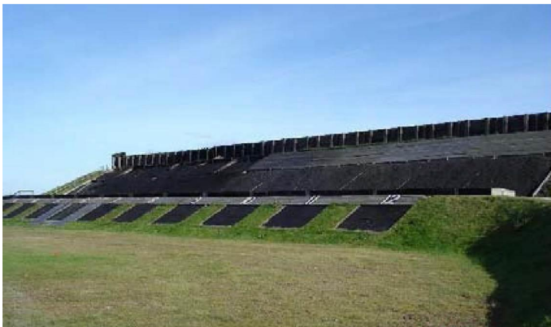
Slika 18: Lovilec z gumijastim granulatom čez celoten nasip pehotnega strelišča (Vir: TAS (RE), 2009)
