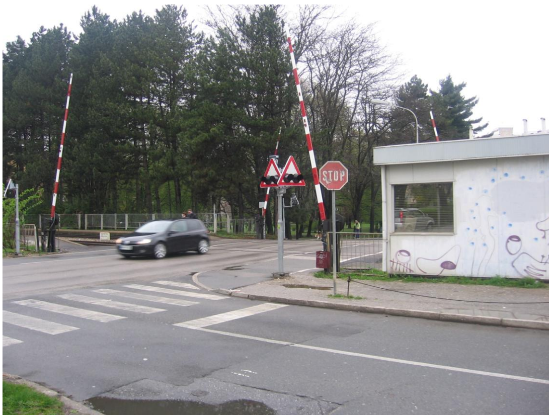
Slika 8: Nivojski prehod z mehanskimi zapornicami v Mariboru
