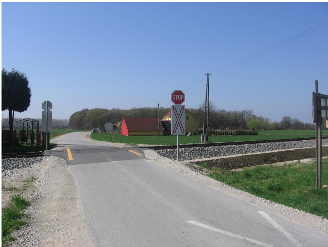
Slika 5: Nezavarovan nivojski prehod, opremljen z Andrejevim križem v Podvincih VIR: Marjeta Babnik, april 2010
