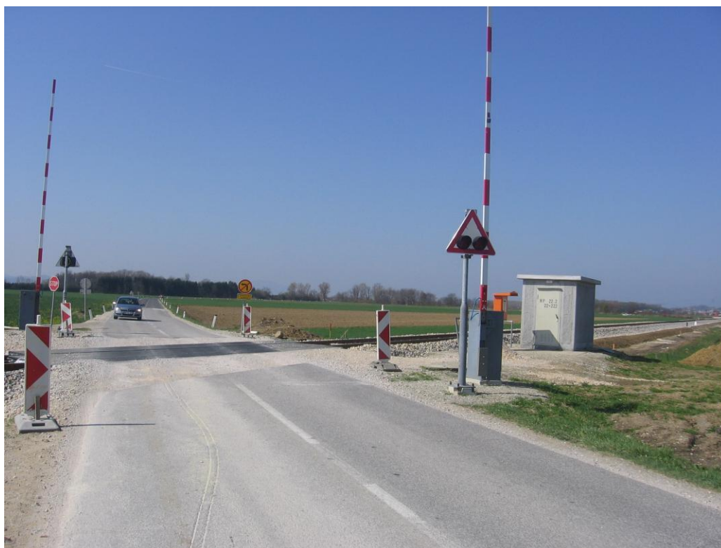
Slika 4: Nivojski prehod z avtomatskimi zapornicami
