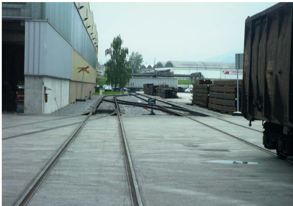
Slika 5 :Potni prehod na industrijskem tiru Merkur Kranj
