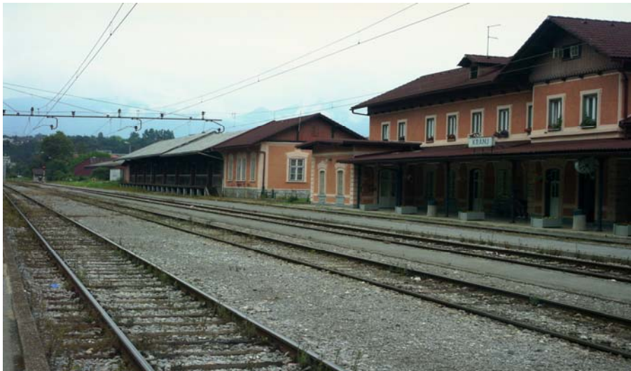
Slika 1 :Železniška postaja Kranj Vir: Ivo Bajec; junij 2007
