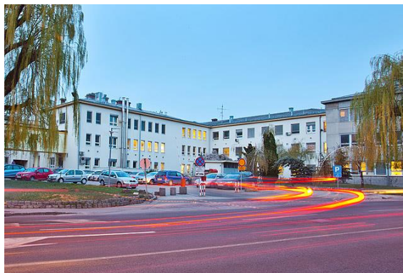
Slika 4: Zdravstveni dom Kranj (Vir: arhiv ZD Kranj)
