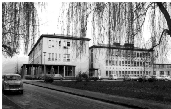
Slika 1: ZD Kranj, 1. avgust 1959 (Vir: arhiv ZD Kranj)
