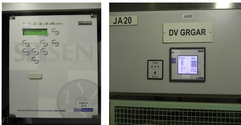
Slika 3: Zaščitni rele FPC520 in LCD-prikazovalnik LDU 700 (Lastni vir)
