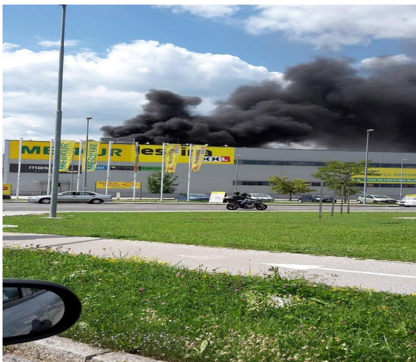
Slika 8 Požar fotovoltaičnih celic, poslovni objekt Merkur Kranj
