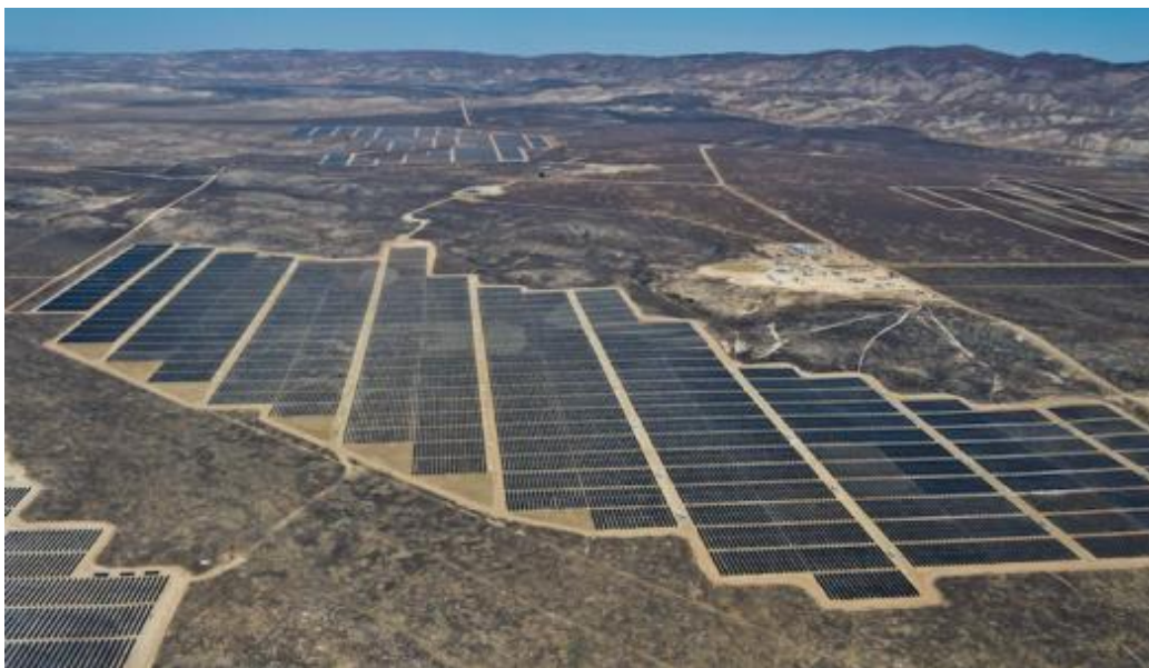
Slika 5: Primer samostoječega talnega fotonapetostnega sistema (Vir: http://www.californiavalleysolarranch.com/california-valley-solar-ranch.html , dostopno 29. 4. 2019. )
