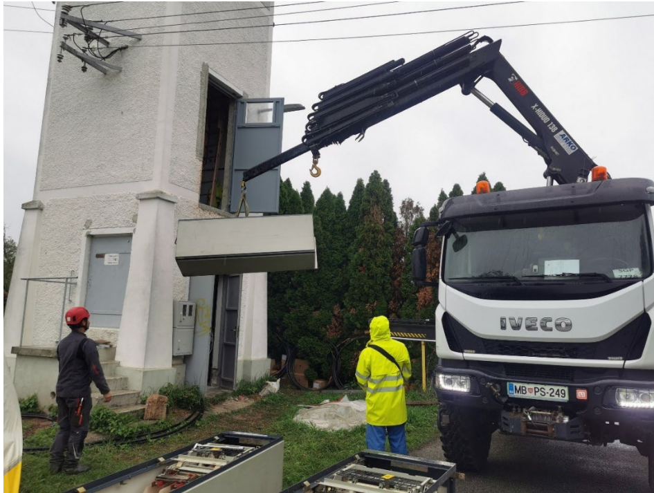
Slika 8: Postopek iznosa starega stikalnega bloka iz TP (Lastni vir)
