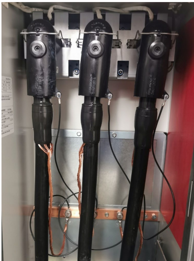
Slika 15: Nameščeni oklopljeni ločljivi kotni konektor (Lastni vir)
