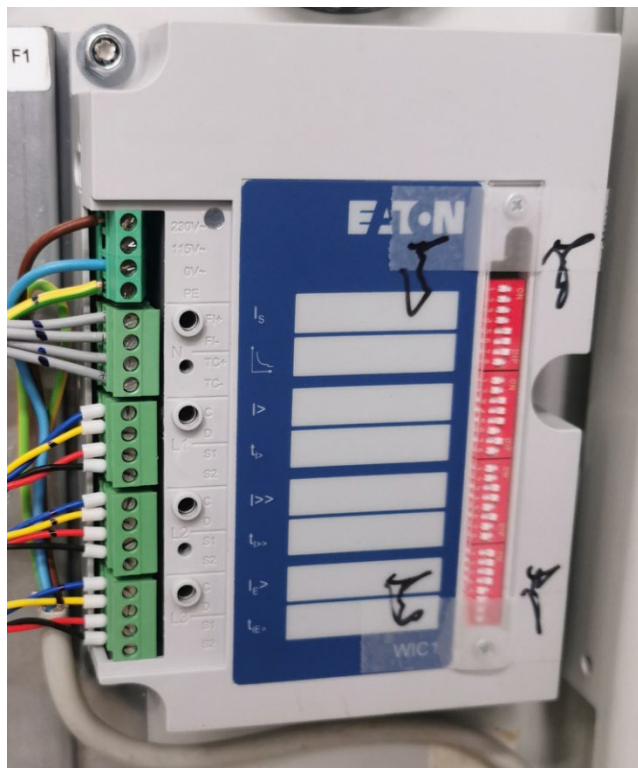
Slika 18: Zaščitni rele WIC1 (Lastni vir)
