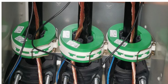
Slika 17: Objemni tokovni transformator nameščen na kable (Lastni vir)
