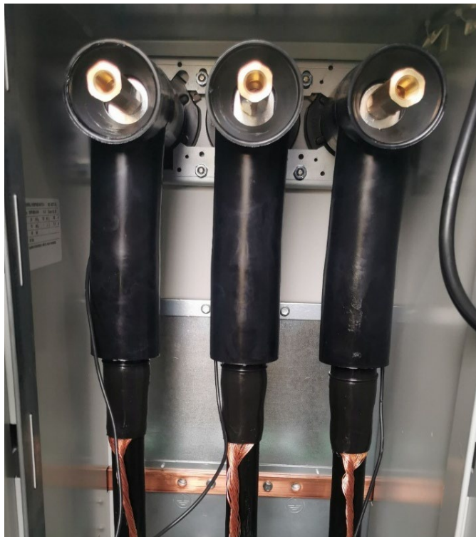
Slika 14: Nameščeni okljopljeni ločljivi T konektor (Lastni vir)
