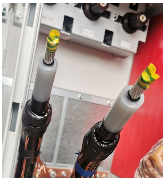
Slika 13: Pripravljene kabli za namestitev oklopljenih konektorjev (Lastni vir)
