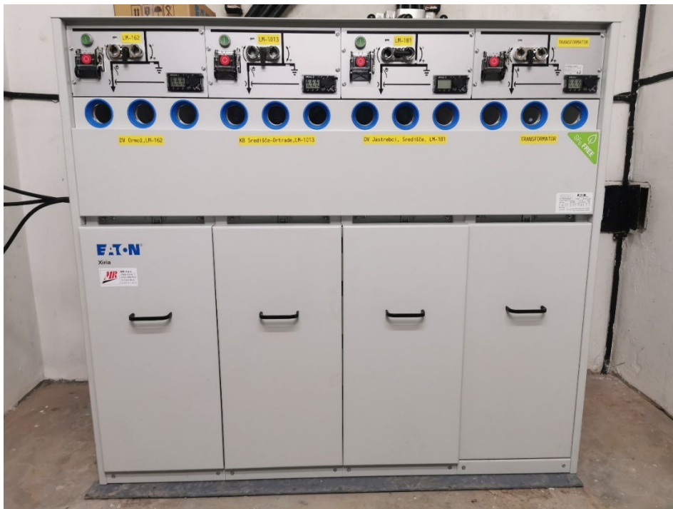
Slika 9: Xiria nameščena na kovinskem nosilcu v TP (Lastni vir)
