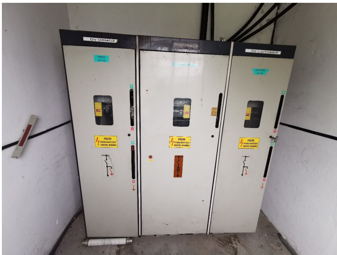
Slika 6: Obstoječe SN stikališče (Lastni vir)
