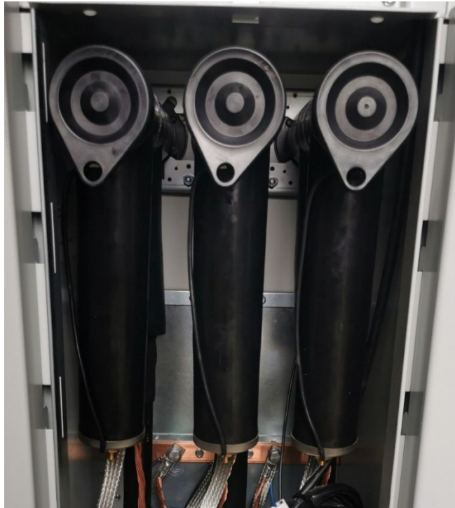
Slika 16: Nameščeni odvodniki prenapetosti za oklopljene ločljive konektorje (Lastni vir)
