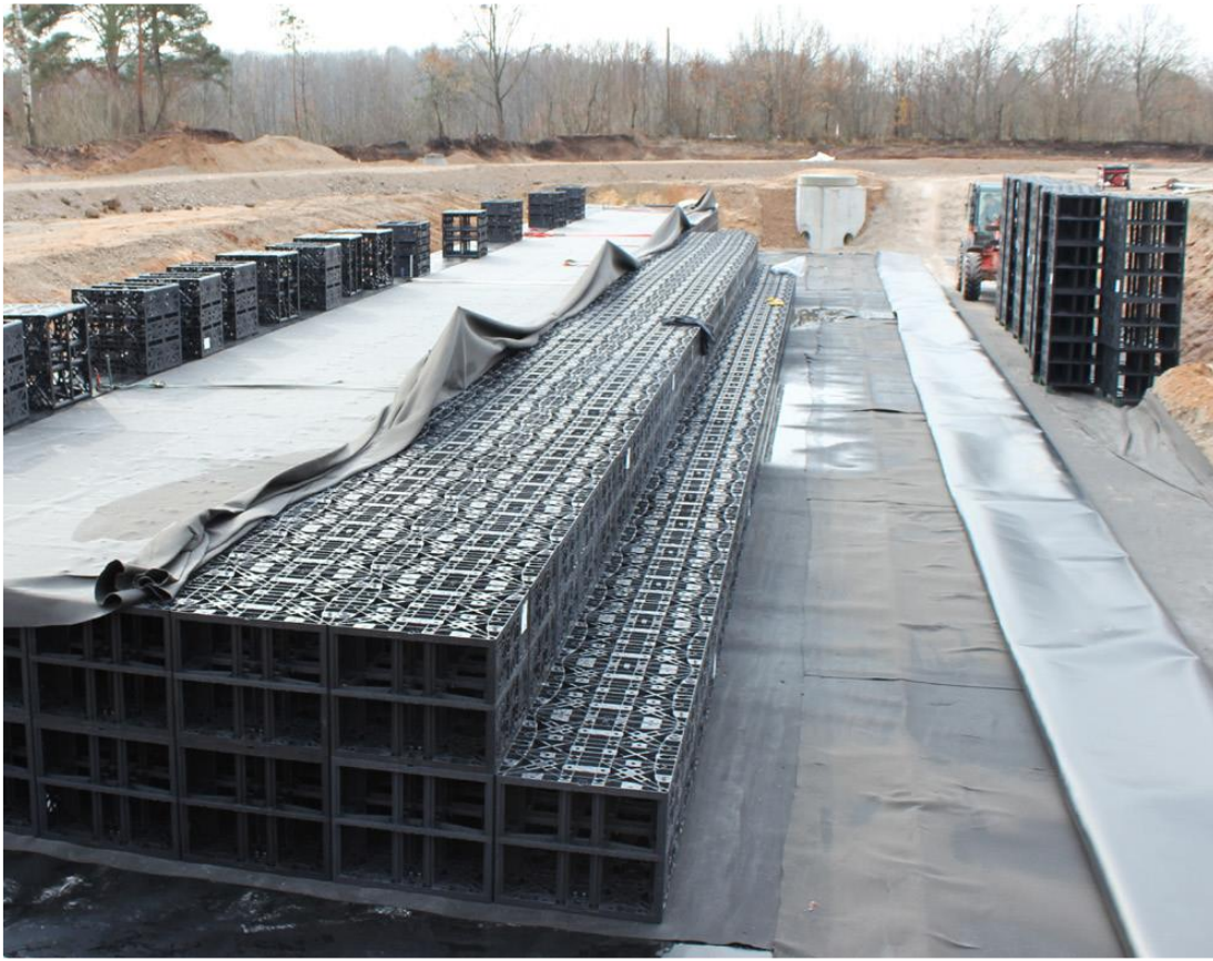
Podzemni rezervoar za vodo 400 m 3
