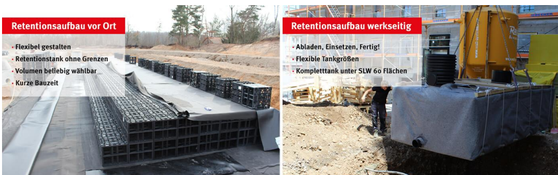
Podzemni rezervoar za vodo 400 m 3
