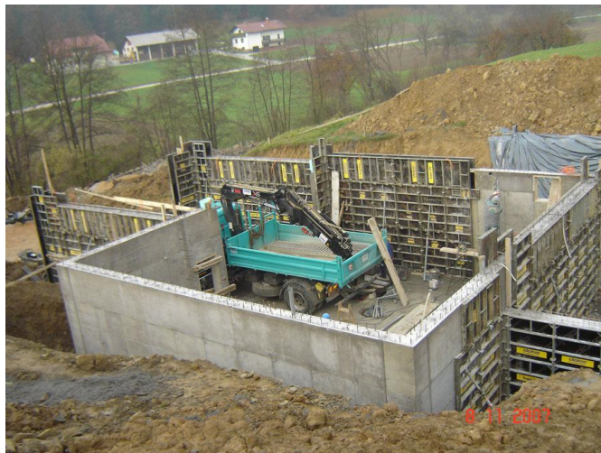
Slika 3: Gradnja armiranobetonskega vodnega zbiralnika z izgradnjo na mestu (Vir: Milan Pušljar, s. p.)
