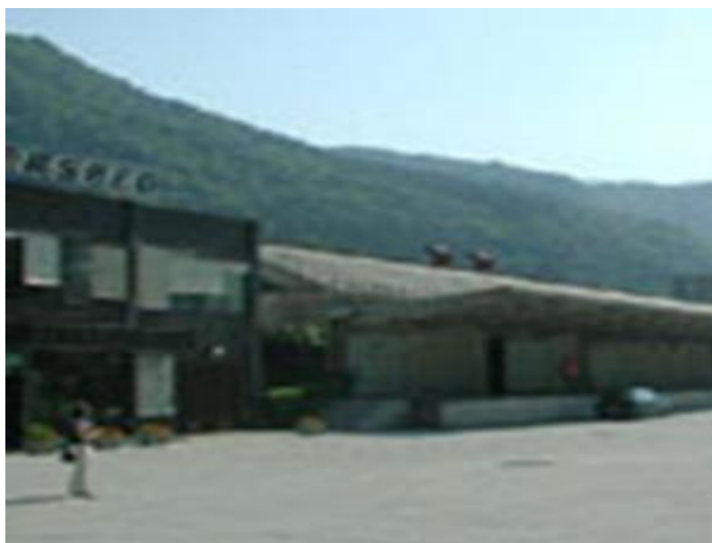
Slika 7: Skladišče SŽ na Spodnjem Plavžu (Vir: Galerija SŽ, d.o.o.)
