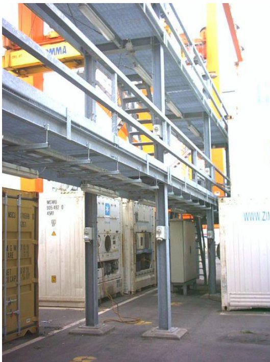
Slika 22: Priključki za frigo kontejnerje Vir: avtor, 2010
