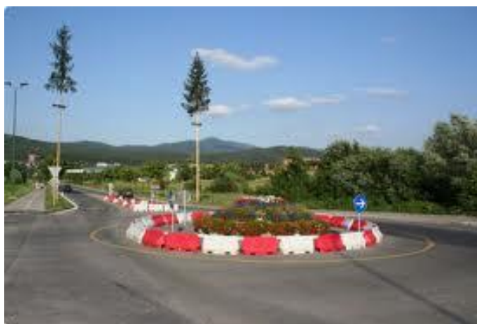
Slika 13: Montažno krožno križišče
