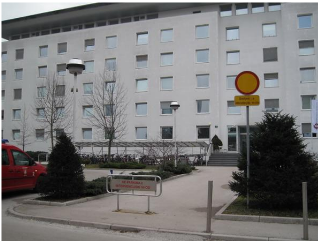
Slika 15: Dodatna zapora. (vir: Gasilska brigada Ljubljana)
