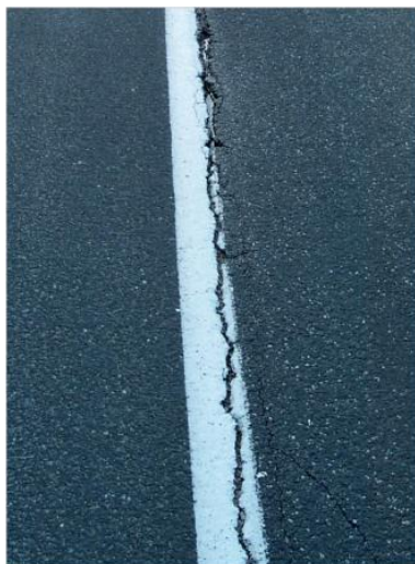
Slika 6: Razpoke na delovnih stikih
