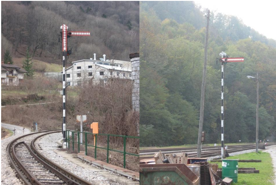
Slika 16: Dvoročni uvozni ter enoročni izvozni signal na Postaji Most na Soči Vir: Lastno gradivo, Goran Jungič
