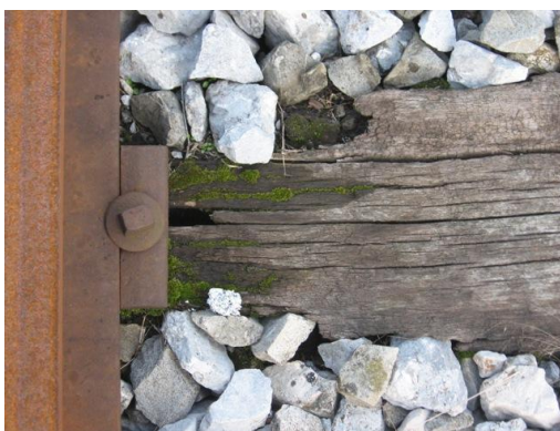
Slika 25: Razpadajoči prag 1 Vir: Lastno gradivo, Goran Jungič
