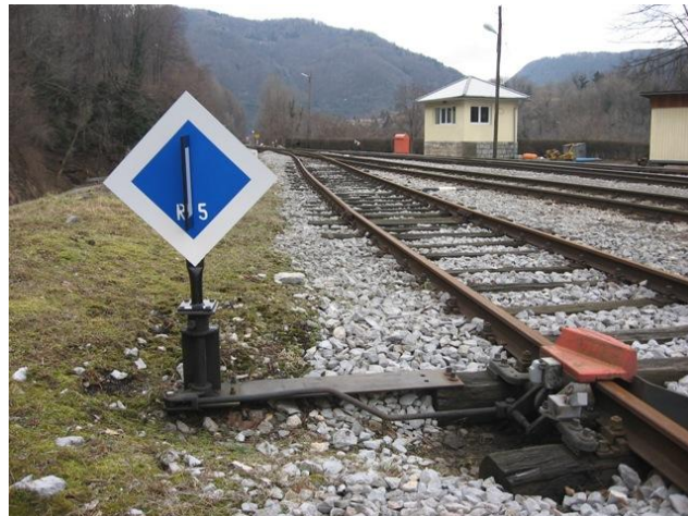
Slika 18: Raztirniki na Postaji Most na Soči Vir: Lastno gradivo, Goran Jungič
