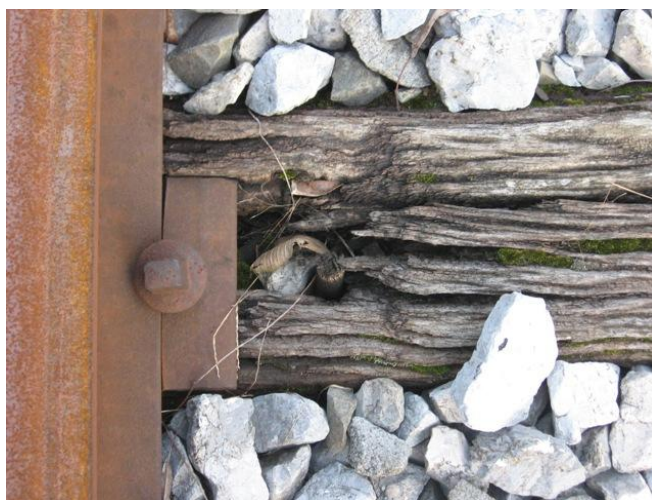
Slika 26: Razpadajoči prag 2 Vir: Lastno gradivo, Goran Jungič
