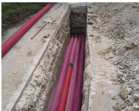
Slika 18: Polaganje kabla v EKK (Vir: Lasten)
