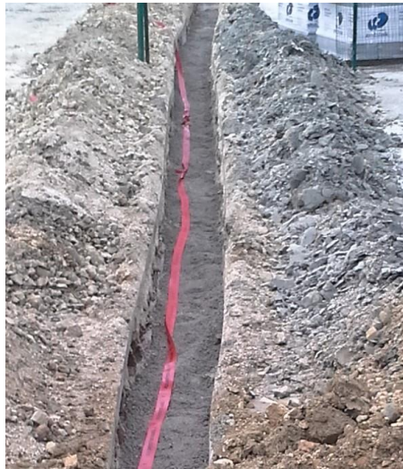
Slika 16: Polaganje opozorilnega traka (Vir: Lasten)
