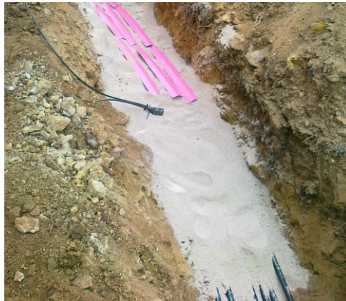
Slika 17: Polaganje kabla v zemljo (Vir: Lasten)
