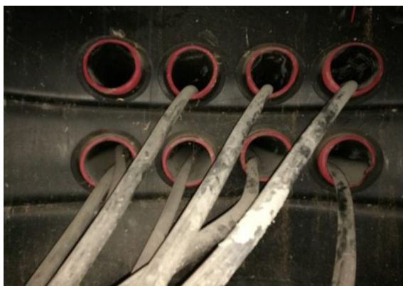
Slika 13: Obstojča EKK (Vir: Lasten)
