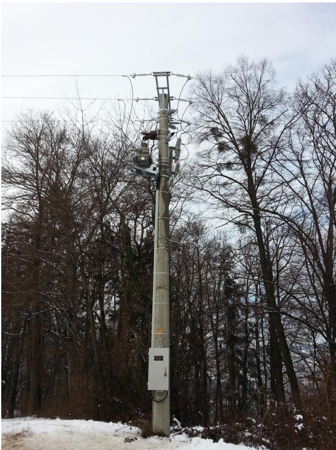
Slika 11: Montaža odklopnika na betonskem drogu (Lastni vir)
