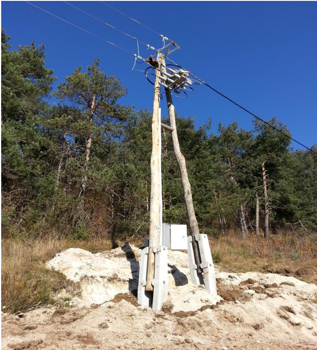
Slika 6: Montaža bremenskega stikala na lesenem A-drogu (Lastni vir)
