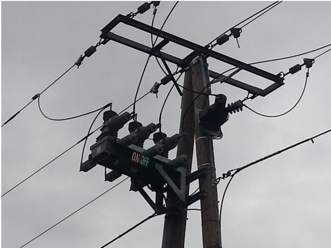
Slika 12: Montaža odklopnika na leseni A-drog (Lastni vir)
