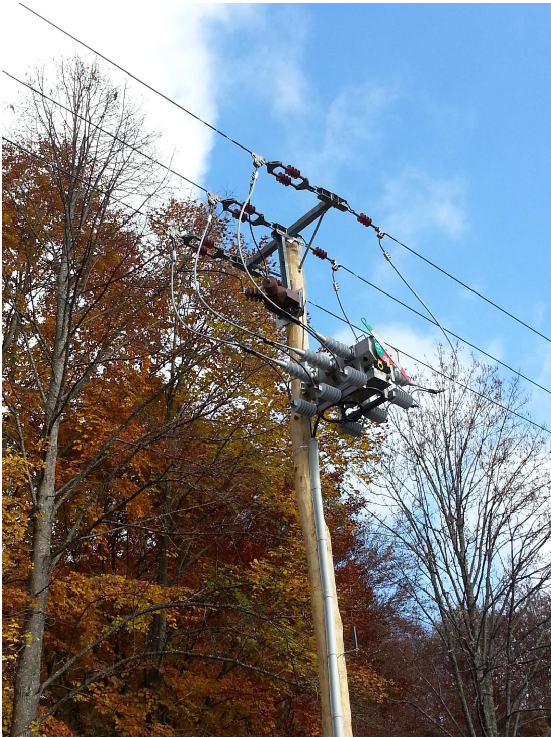
Slika 7: Montaža bremenskega stikala na lesenem drogu (Lastni vir)
