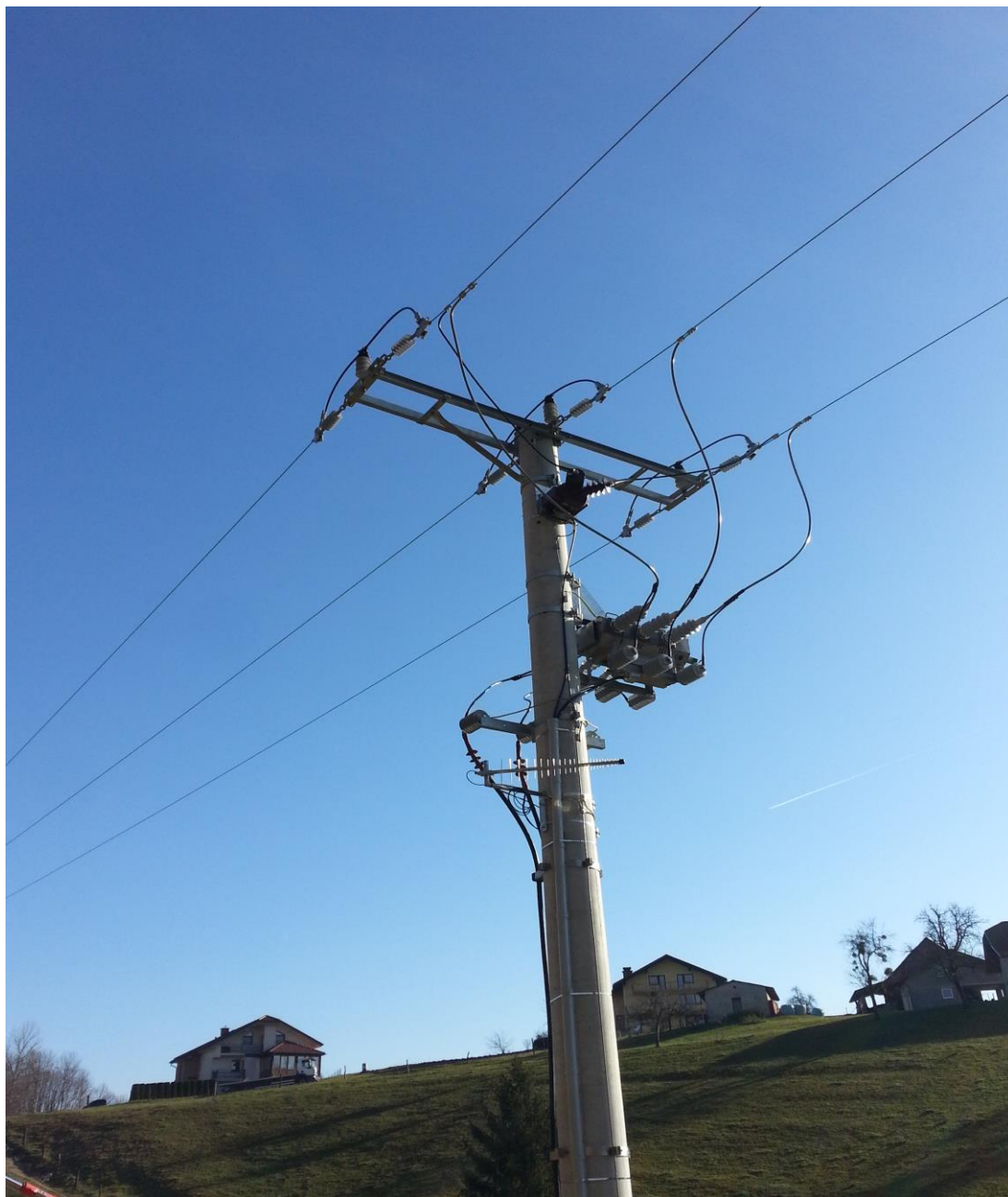
Slika 5: Montaža bremenskega stikala na betonskem drogu (Lastni vir)
