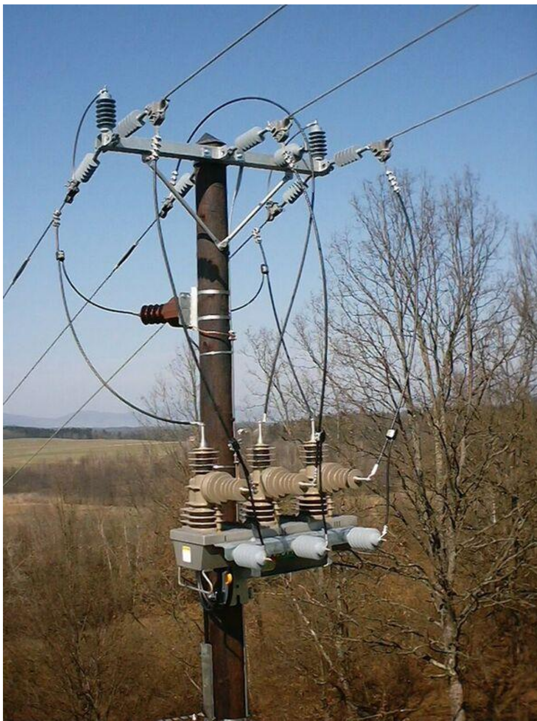
Slika 13: Montaža odklopnika na lesenem drogu (Lastni vir)
