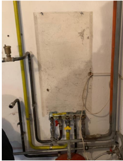
Slika 19: Demontaža kotla (Lastni vir)
