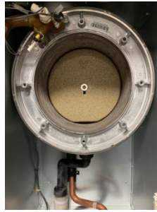
Slika 18: Primarni toplotni izmenjevalec ob prvem servisu (Lastni vir)
