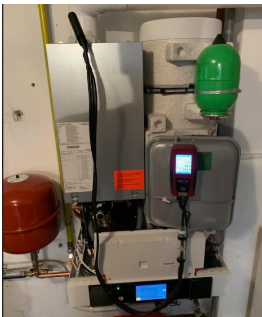
Slika 36: Merjenje dimnih plinov na kondenzacijskem kotlu (Lastni vir)
