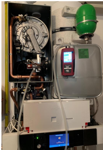
Slika 30: Meritve tlaka plina (Lastni vir)
