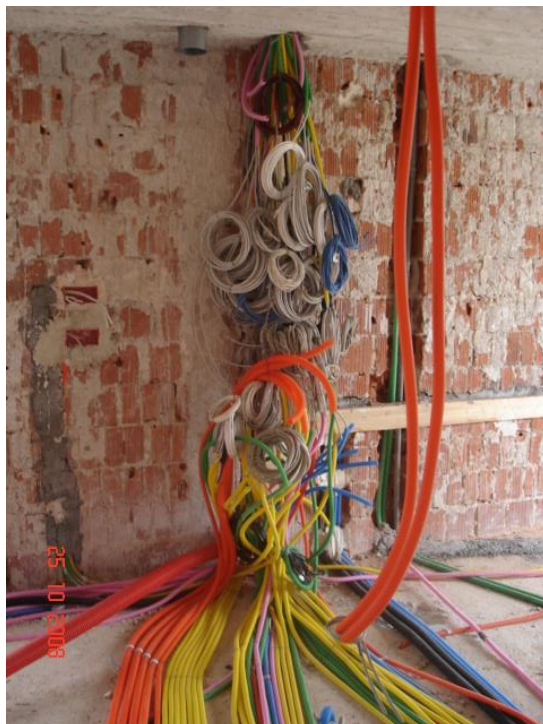
Slika 6: Izvedba grobe inštalacije (lastni vir)
