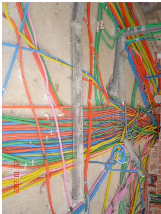
Slika 3: Izvedba grobe inštalacije (lastni vir)
