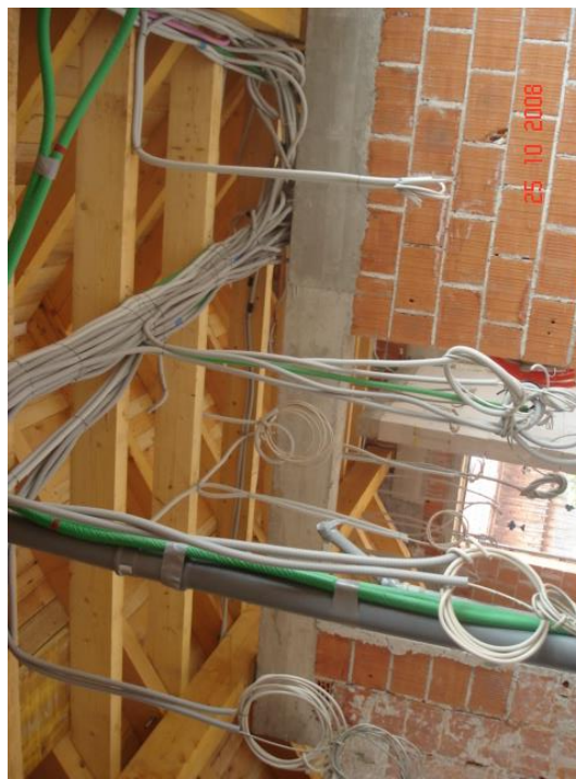
Slika 4: Izvedba grobe inštalacije (lastni vir)
