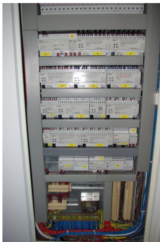
Slika 36: Električni razdelilnik z aktuatorji (lastni vir)
