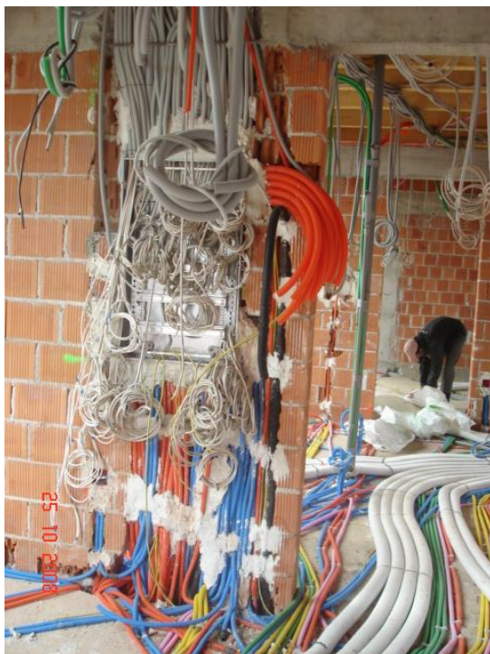
Slika 5: Izvedba grobe inštalacije (lastni vir)
