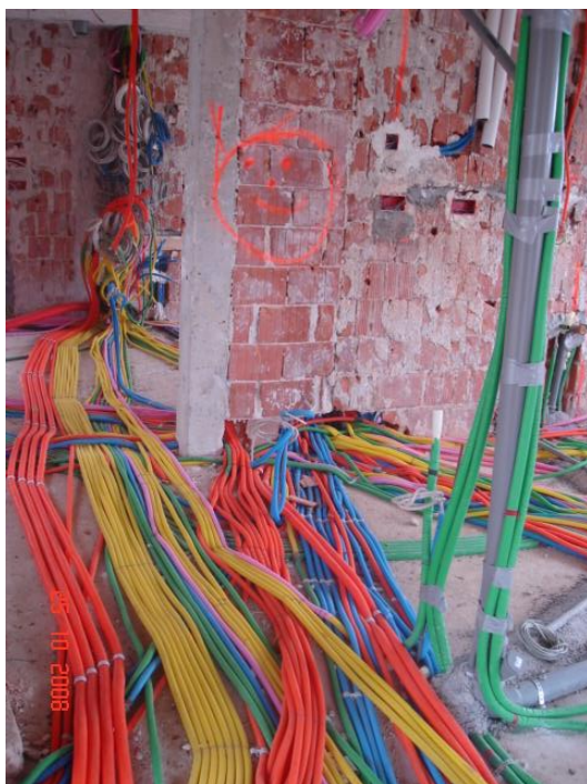
Slika 7: Izvedba grobe inštalacije (lastni vir)
