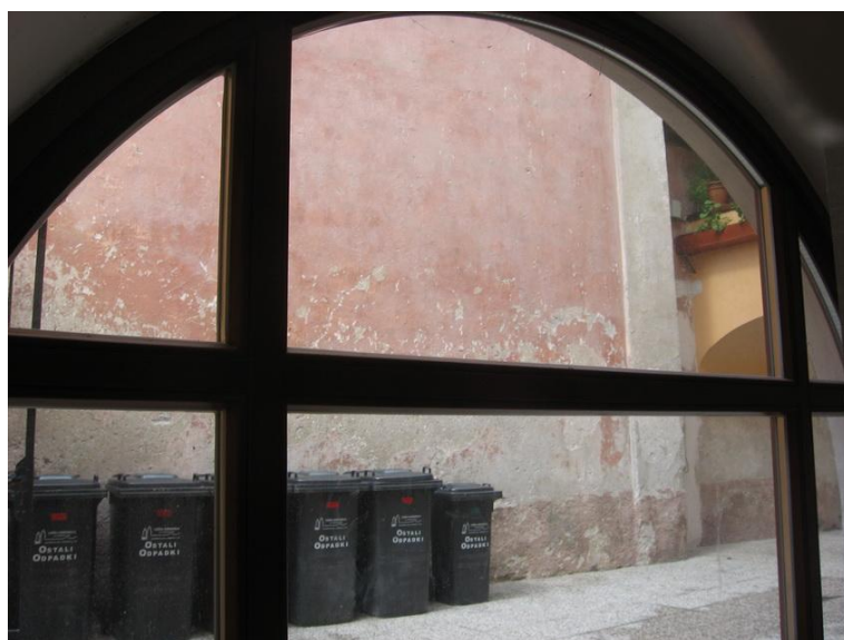
Slika 42: Okna v pisarni 25.4.2009 Vir: lasten
