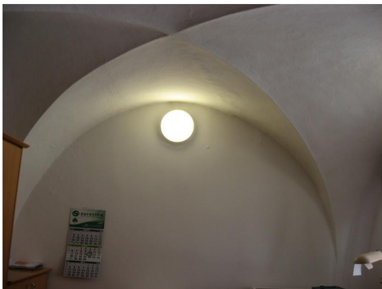
Slika 36: Strop in svetloba 25.4.2009 Vir: lasten
