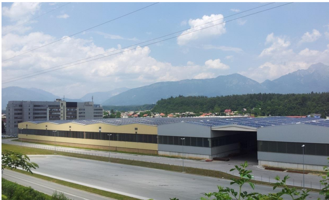
Slika 3: Največja sončna elektrarna na Gorenjskem, ki se nahaja na strehah Merkurja v Naklem (Vir: Interni, GE)
