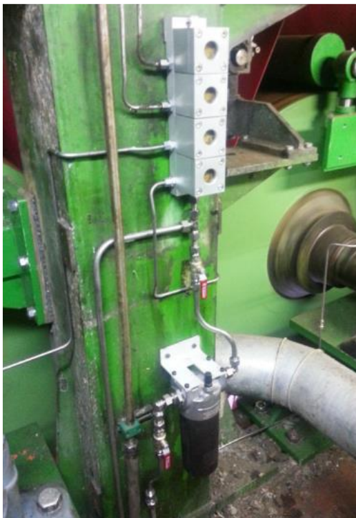
Slika 27: Vgradnja dodatnega filtra (Vir: Dimas d. o. o., 2016)
