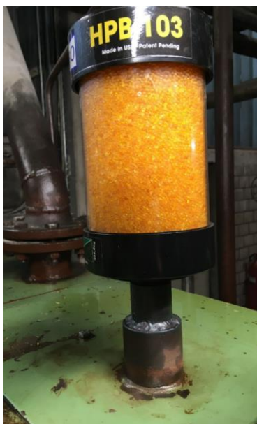
Slika 50: Odzračevalnik s silikagelom HyPro HPB-103 (Vir: Lastni, 2020)
