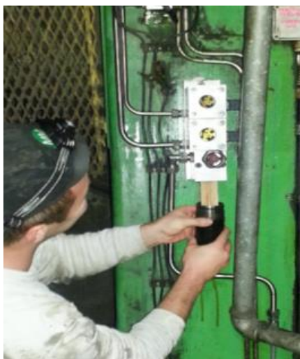
Slika 23: Filter pri omejevalcu pretoka (Vir: Dimas d. o. o., 2016)
