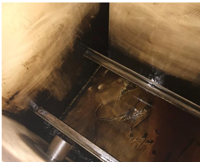
Slika 48: Čiščenje sten rezervoarja s krpami (Vir: Dimas d. o. o., 2020)
