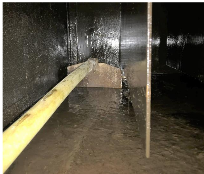
Slika 47: Čiščenje rezervoarja – usedline (Vir: Dimas d. o. o., 2020)
