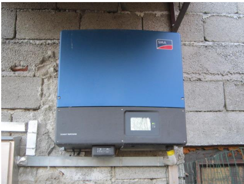
Slika 5: Razsmernik SMA 17000 TL (Vir: lasten; simbolična slika)
