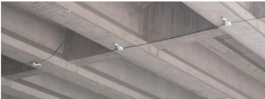
Slika 4: Postavitev merilnih senzorjev
