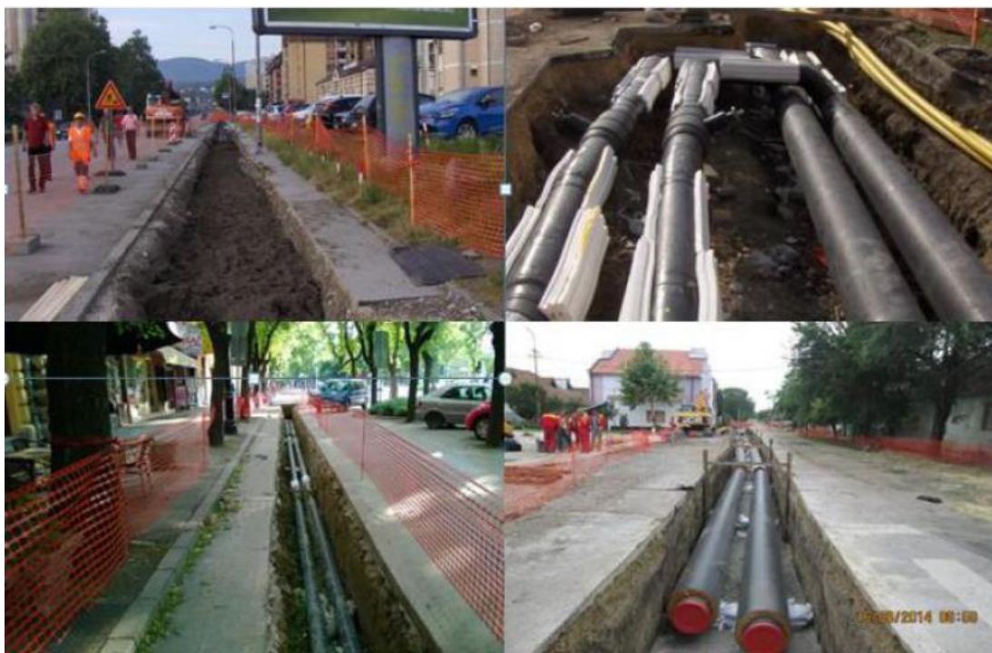
Slika 28: Izkop kanalov za cevi daljinskega ogrevanja
