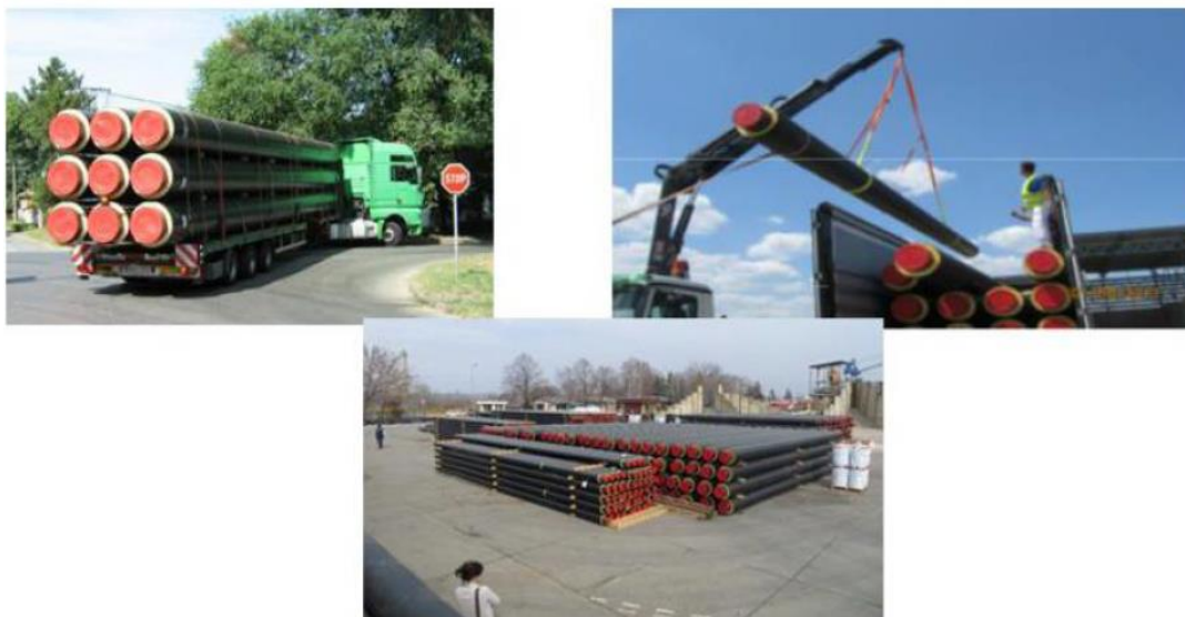
Slika 27: Nove cevi za optimizacijo toplovoda sistema daljinskega ogrevanja (Vir: Beogradske Elektrane, predstavitev učinkov projekta optimizacije Sistema daljinskega ogrevanja)
