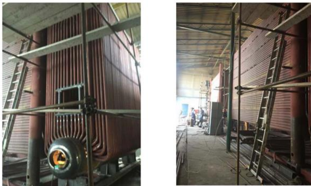
Slika 32: Obnova kotlov – Niš – 2 × 30 MW
