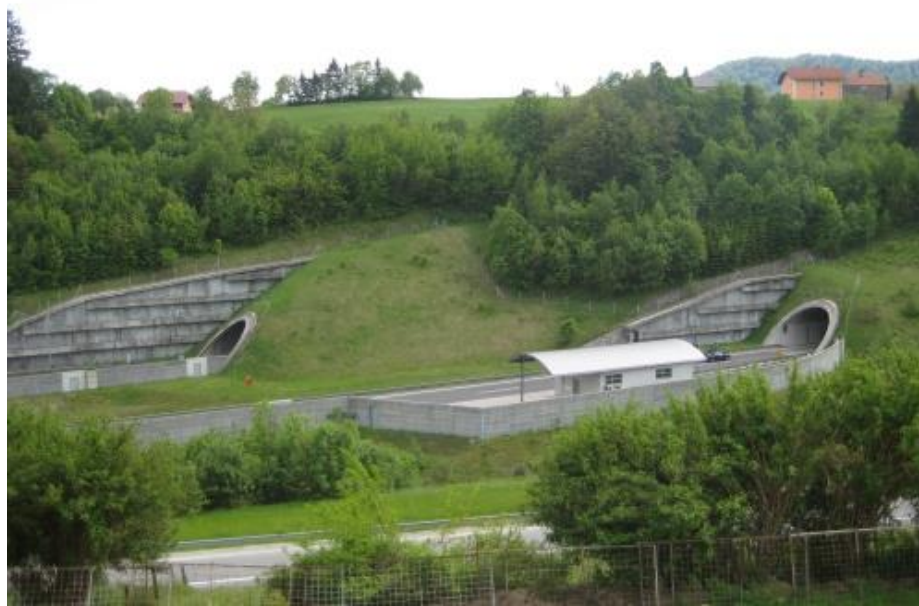
Slika 7: Stavbe nad predorom Trojane (Vir: Lasten)
