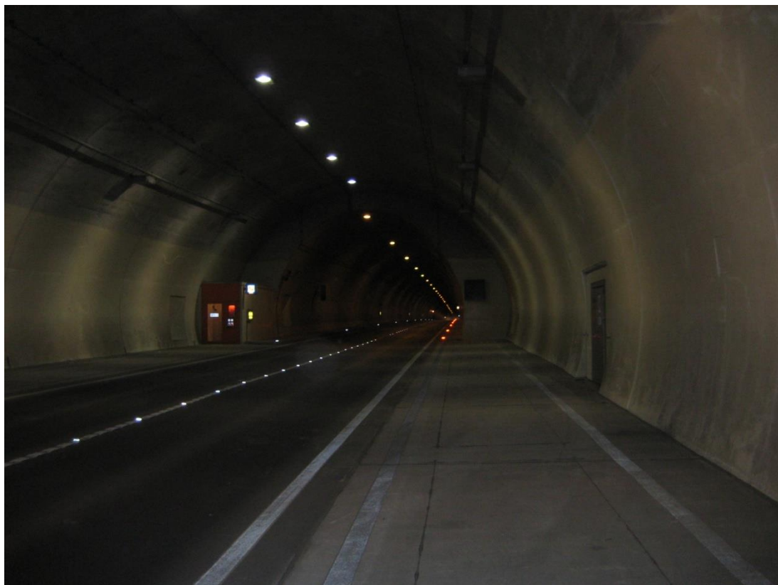
Slika 10: Odstavna niša v predoru (Vir: Lasten)
