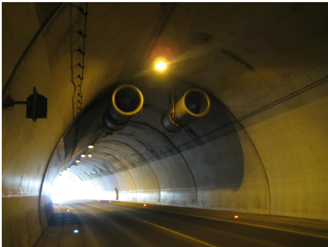
Slika 17: Predor z razsvetljavo in prezračevalnim sistemom (Vir: Lasten)
