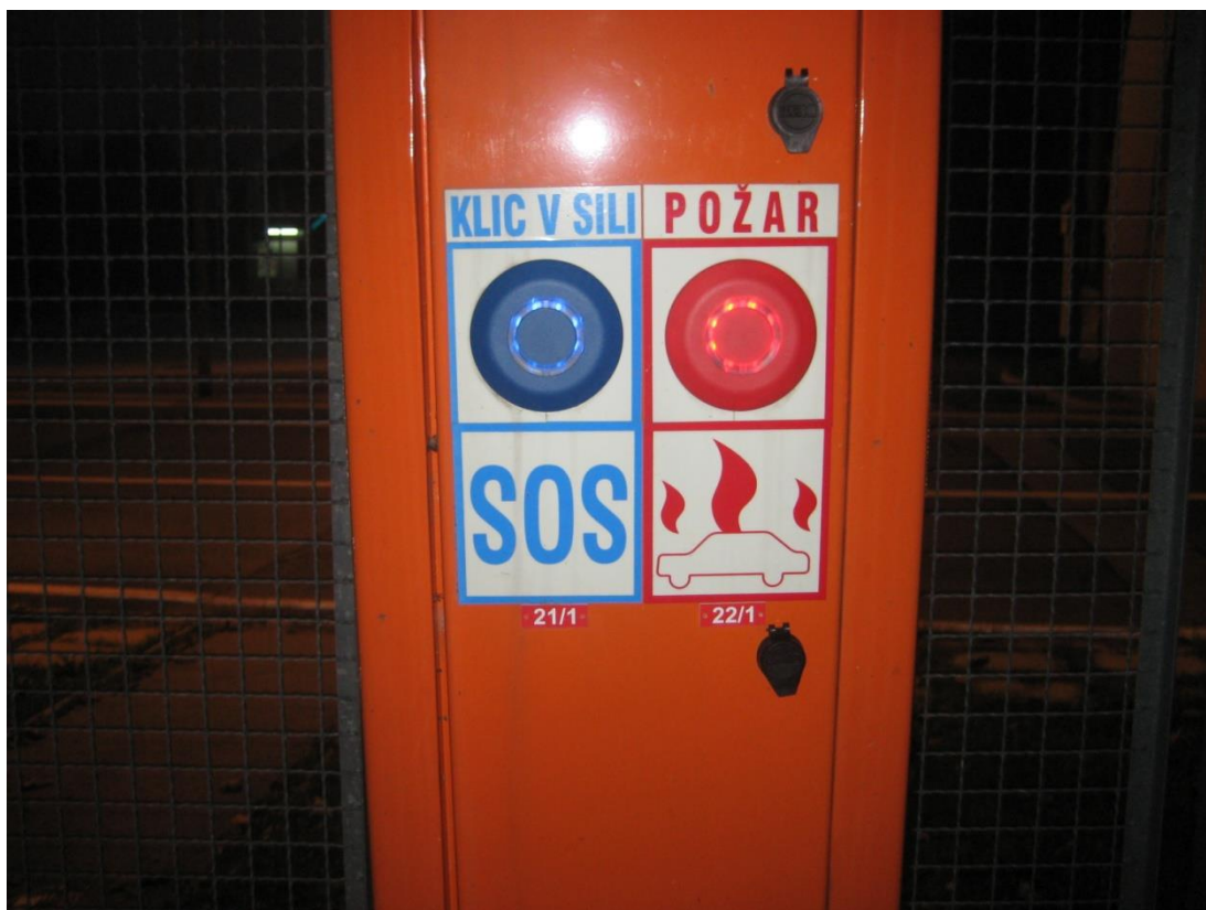
Slika 4: Ročni sistem za javljanje požara in klica v sili pred predorom (Vir: Lasten)
