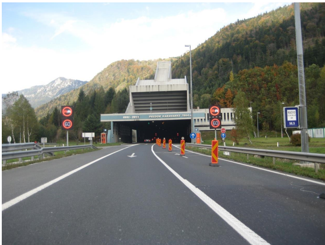
Slika 6: Vhod v predor Karavanke v času obnovitvenih del v predoru (Vir: Lasten)
