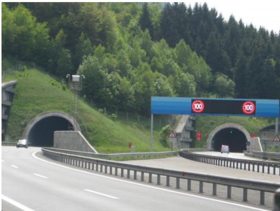
Slika 14: Prometna signalizacija pred vstopom v predor Trojane iz smeri Štajerske proti Ljubljani (Vir: Lasten)
