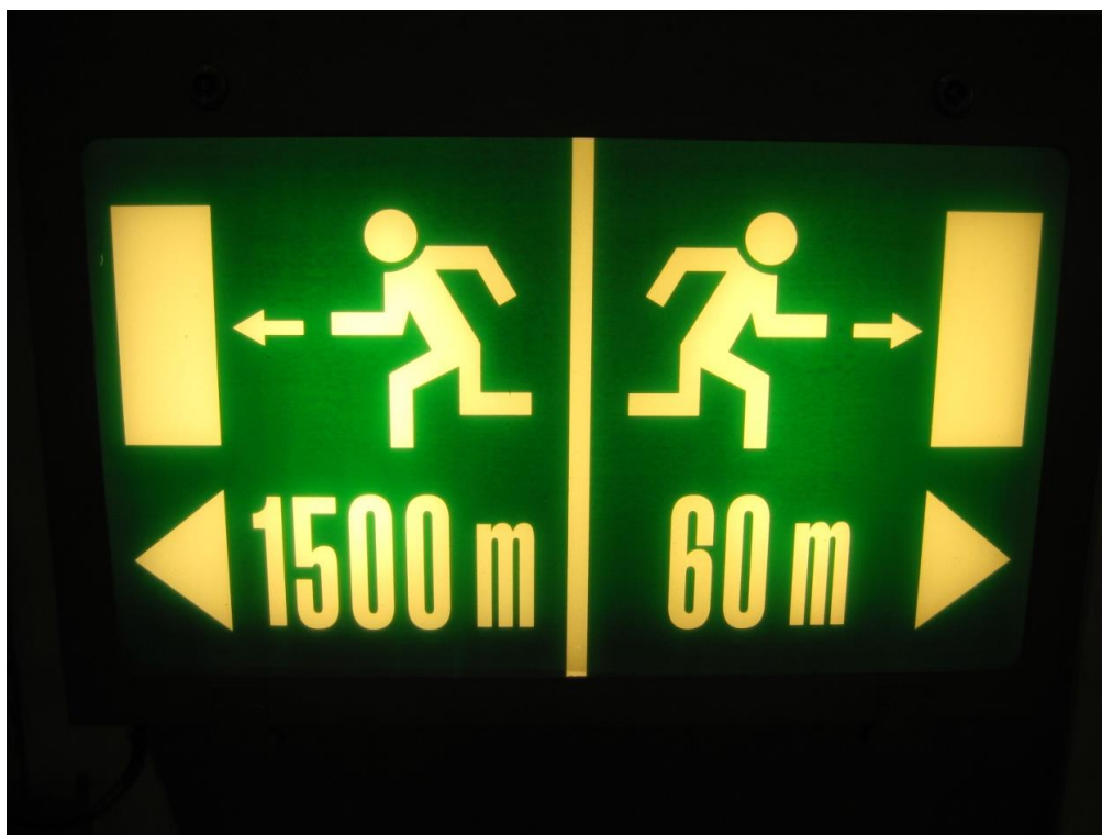
Slika 18: Smerna svetilka v predoru (Vir: Lasten)
