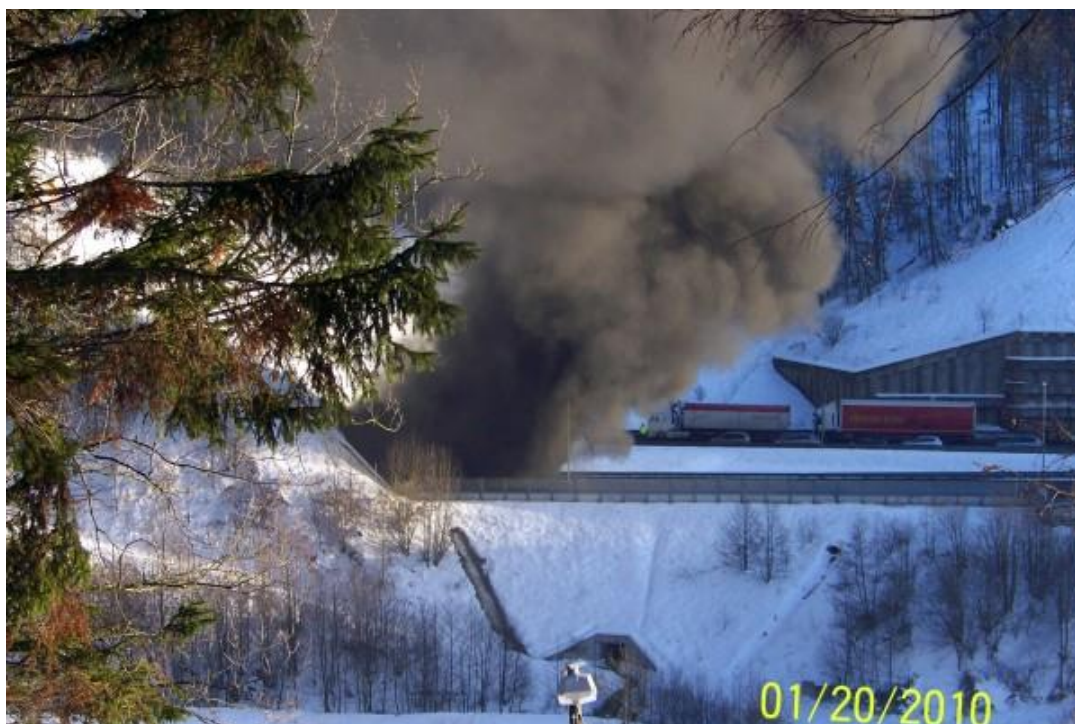
Slika 9: Požar v predoru Trojane
