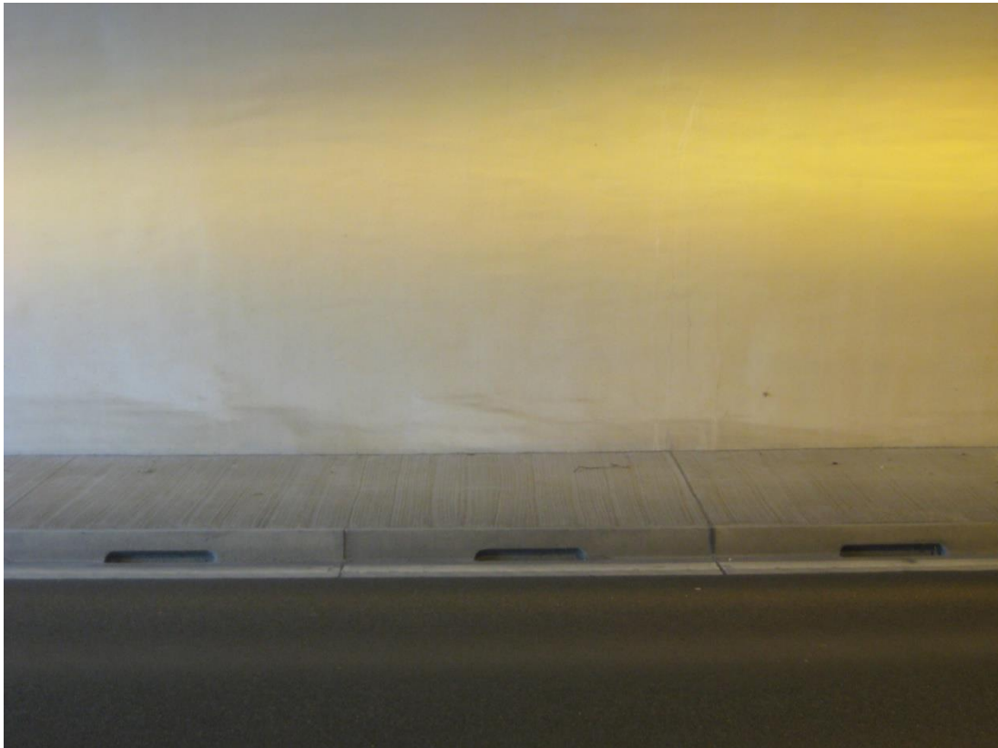
Slika 8: Robniki v predoru z odprtinami za primer razlitja tekočih snovi (Vir: Lasten)
