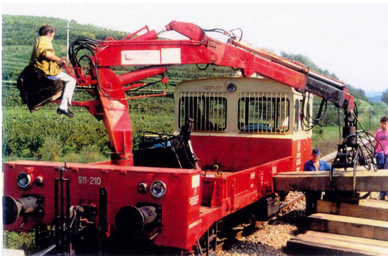
Slika 40: TMD 911 – za vzdrževanje proge VIR: SŽ; Infrastruktura, 2010
