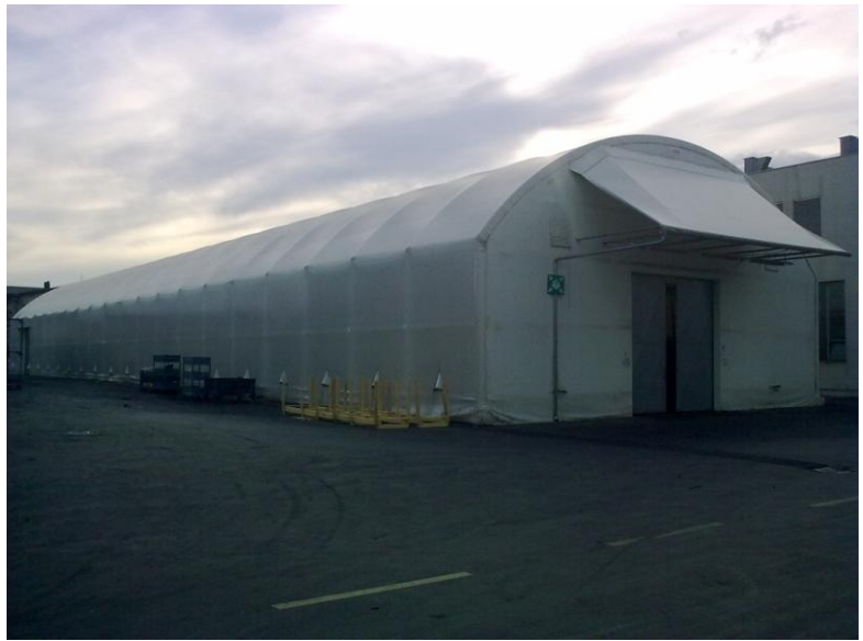
Slika 2: Skladišče J-60 (Avtor: Marković, 2010)
