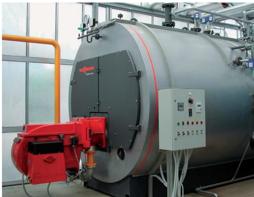
Slika 3: Mnogovodni kotel (Vir: Dampfkessel: auslegung, b. I.)
