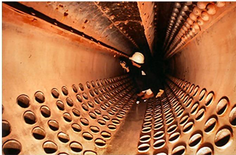
Slika 5: Inšpektor ob notranjem pregledu kotla (Vir: Water problems, 2016)
