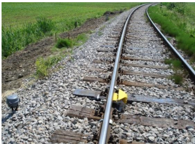
Slika 24: Magnetni tirni kontakt (MTK)
