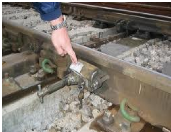
Slika 7: Kretniška ključavnica s ključem (vir: http://www.servisna-oprema.si/private/zeleznica/kljucavnica.jpg )
