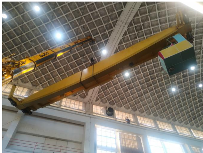
Slika 6: Spuščanje mostnega nosilca. (Lastni vir.)
