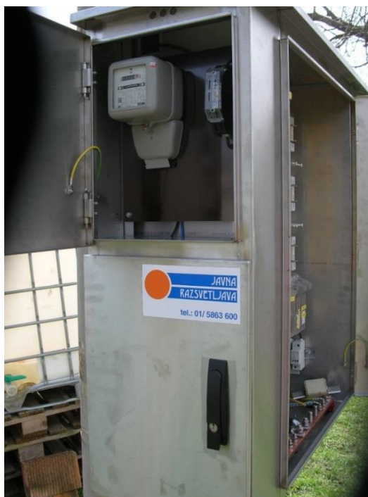
Slika 5: Izgled ločenih omaric javne razsvetljave (Lastni vir)
