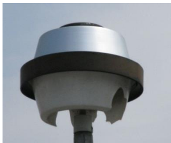
Slika 16: Svetilka Elektrokovina UD (Vir: arhiv Elektro Primorska)
