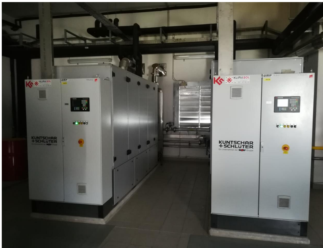
Slika 11: Obstoječi 100 kW bioplinski kogeneraciji v CČN Kranj (Vir: Lastni, december 2018)
