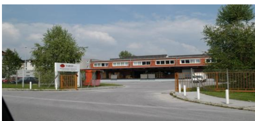
Slika 3: Vir: Google slike, Logistični center Sabod
