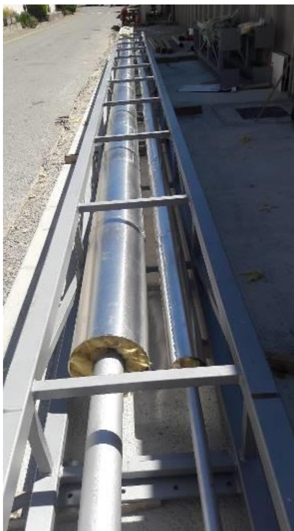
Slika 19: Izolirana parna cev (Lastni vir)
