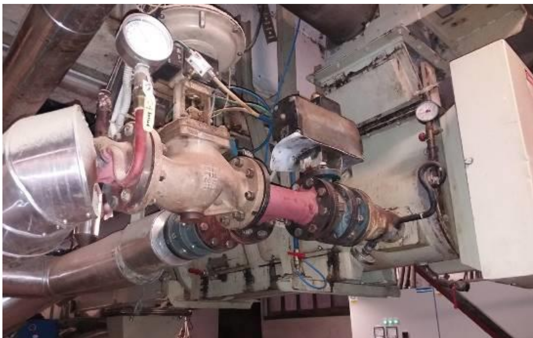
Slika 13: Dovod pare v kondicioner v Jati Emoni (Lastni vir)
