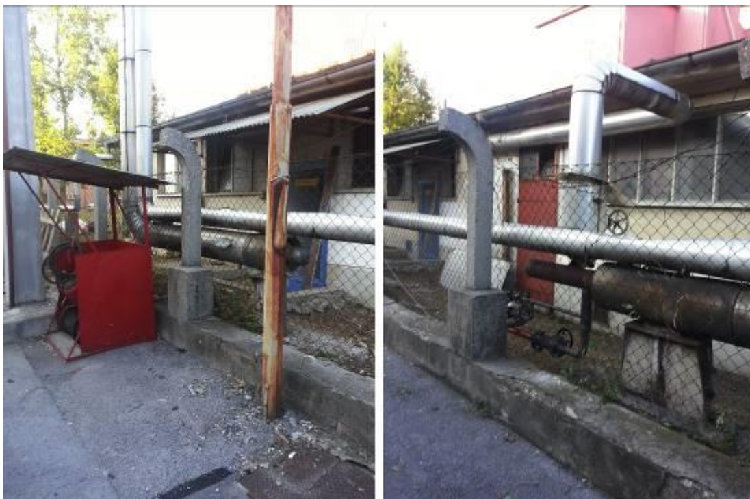
Slika 12: Prekinitev parovoda pred Jato Emono (Lastni vir)
