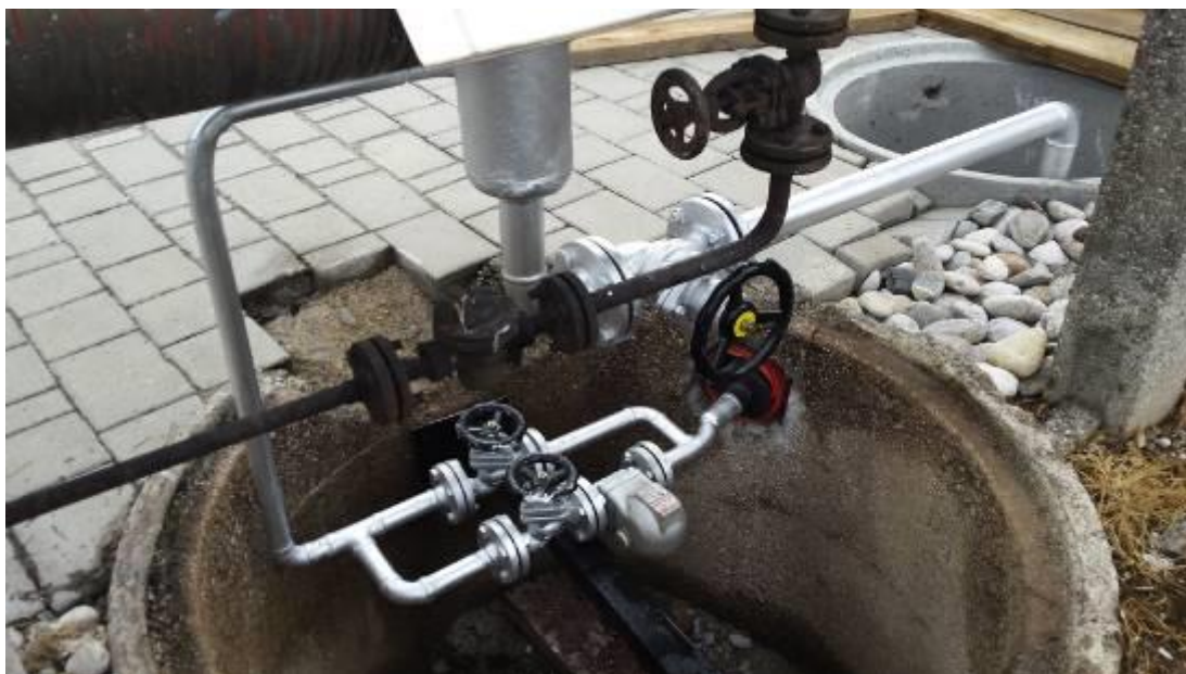
Slika 14: Parovodni jašek (Lastni vir)
